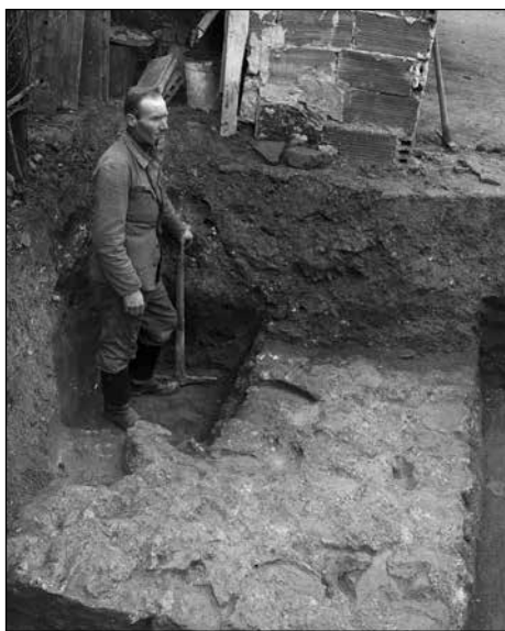
15. kép: Az Ulcisia 4. őrtorony feltárása (Aquincumi Múzeum Archiv Fotótára, ltsz. A488) Fig. 15. Excavation of watchtower Ulcisia 4 (Photo Archive of the Aquincum Museum, inv. no. A488)
