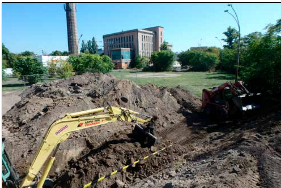
22. kép: Váci út 160–168. Az 1. kutatószonda gépi földkiemelése az egykori Angyalföldi Erőmű délnyugati részén (Tóth Farkas Márton)
