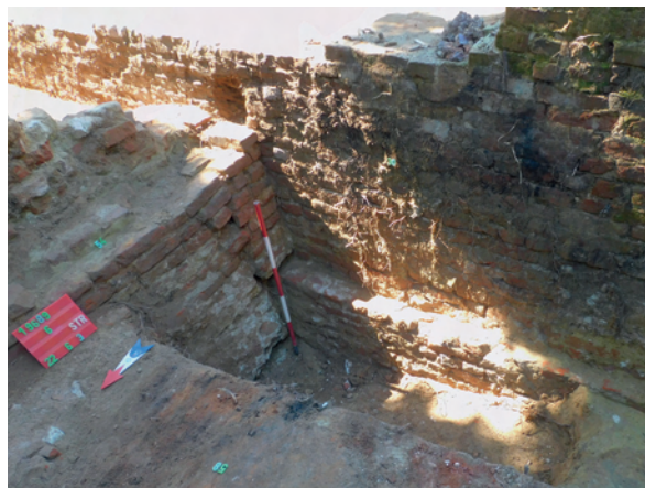
13. ábra. A délnyugati várfalhoz épített fal alapozása, előtérben török kori megégett járószint
