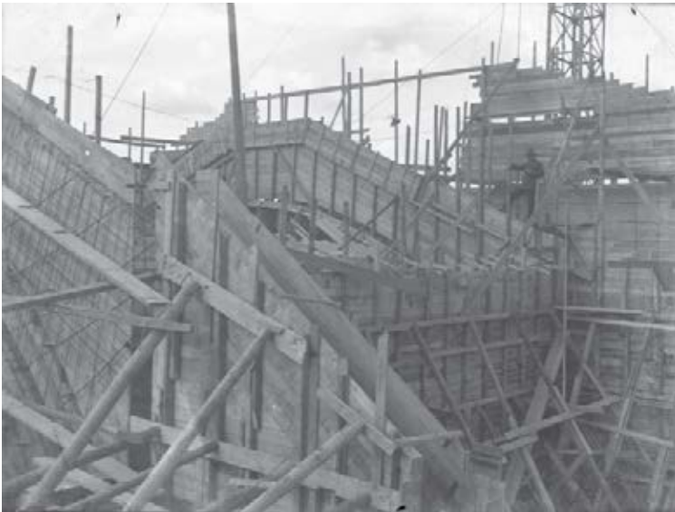
Deszkázat az épülő Debreceni Egyetem tetején a homlokzati rész kialakításánál, 1929, Haas Károly felvétele
