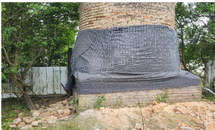
6. ábra: A megépített repeszvédelem
