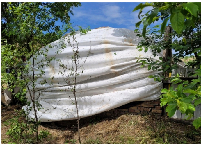
8. ábra: Repszvédelem a robbantási sávval ellentétes oldalon
