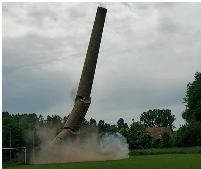
7. ábra: A kémény dőlés közben – ahogy három részre törik Forrás: a szerző felvétele
