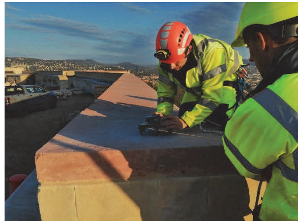
7. ábra. Pillérállvány felállítás az M6 ponton.
