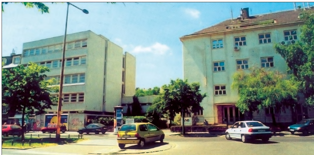
1. ábra. Az MTA Enzimológiai (korábban Biokémiai) Intézetének épületei a Karolina út 29–31. alatt. Jobb oldalon a volt honvédségi, régebbi (A) épület, bal oldalon az 1969-ben átadott, újabb (B) épület.
