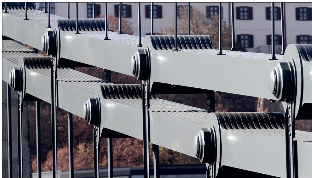
5. ábra. Lánckötegek az új korrózióvédelmi bevonattal Forrás: BME Hidak és Szerkezetek Tanszék
