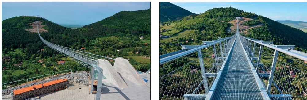
1. ábra. A megépült hídszerkezet
