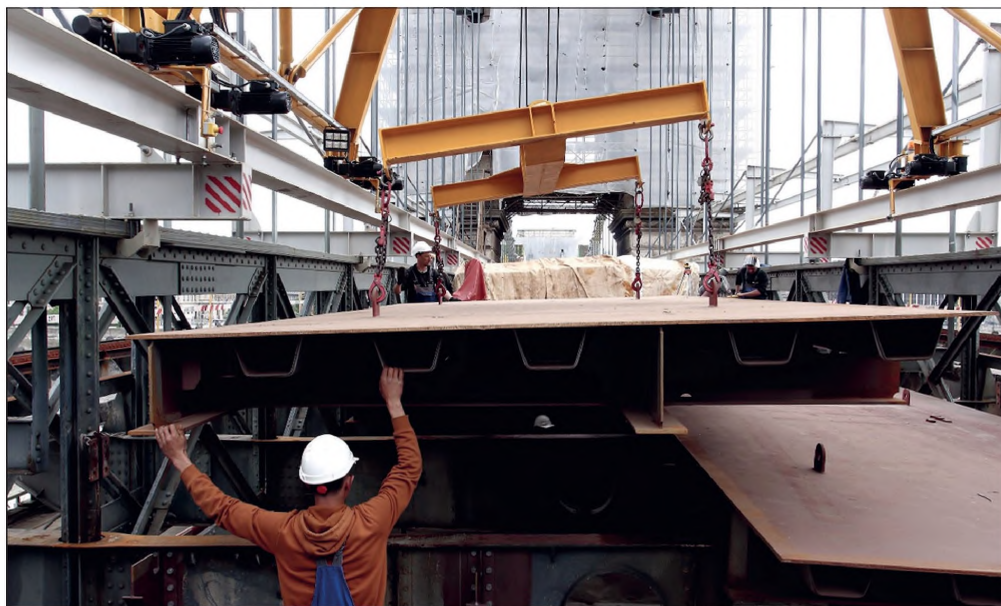
4. ábra. Új pályalemez beemelése
