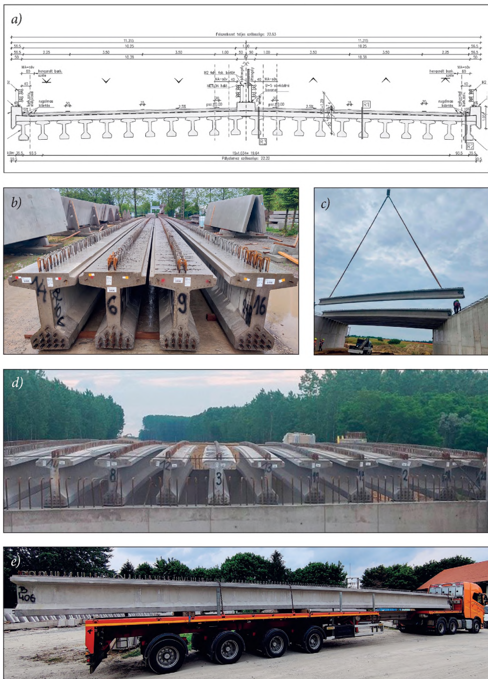
5. ábra. a-e) ZBI-90/21,80 gerendák beépítése Forrás: ZÁÉV, Hartmann Péter
