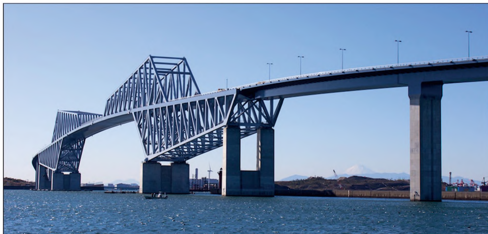
1. ábra. Tokyo Gate híd – nagy szilárdságú acélrácsos tartó
