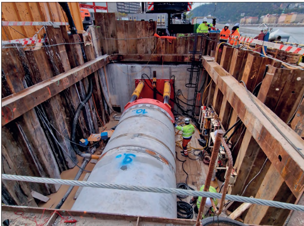
12. ábra. Csőátvezetés kiépítése mikrotunnelling technológiával Forrás: Főmterv Zrt.
