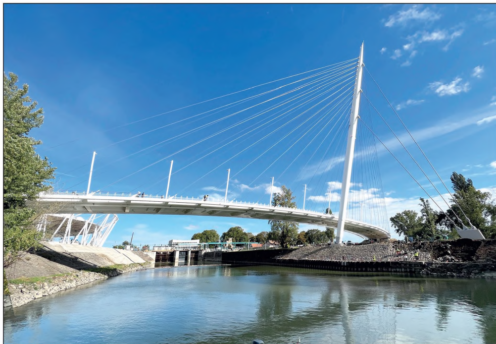
5. ábra. A folyó fölött átívelő hídszerkezet látványa Forrás: Speciálterv Kft.
