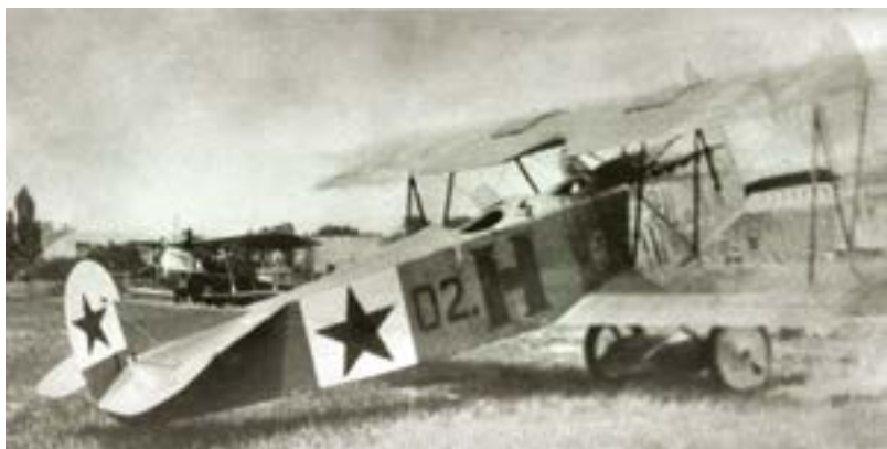
3. ÁBRA. Az egyetlen ismert fotó a H.02-es jobb oldaláról, elől a Daimler-motor hat kipufogócsöve látható. A hátsó ülésnél a géptörzsre egy repülőműszert szereltek (Forrás: Winkler Aero Archiv)
