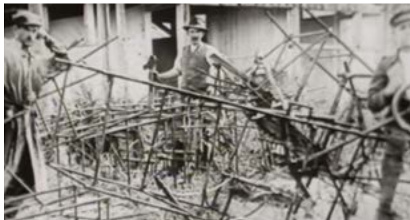
8. ÁBRA. Mátyásföldön 1921-ben az antant békeszerződés részeként megsemmisítik a Fokker D.VII-esek részére készített acélsővázakat. A MAEFORT-nak gyártottak volna civil felhasználású MÁG kétüléses repülőgépeket (Forrás: Winkler Aero Archiv)
