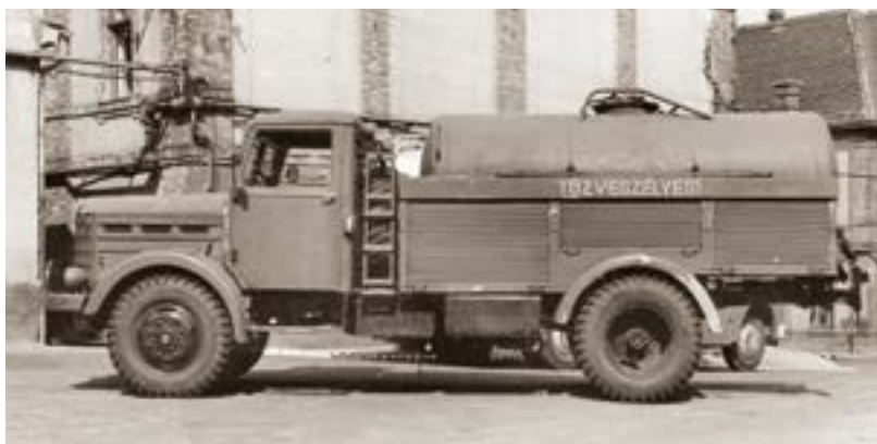
2. ÁBRA. Csepel D-346 középdómós üzemanyagtöltő gépkocsi (Forrás: HTarchívum)
