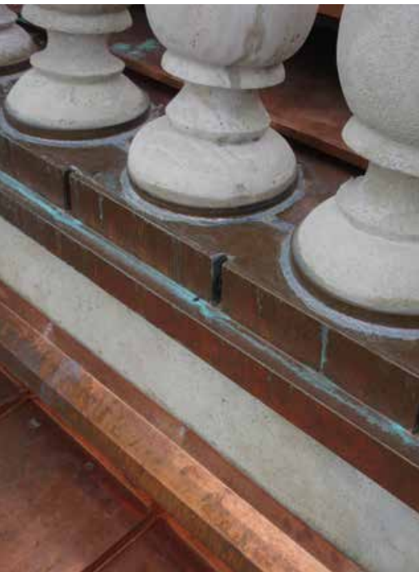
5. kép A balusztrádok szegélyezésének elkészült változata, mögötte a rejtett csatornával. (Fotó: dr. Birghoffer Péter)
