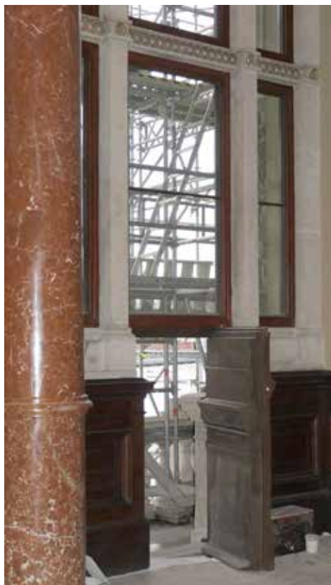
6. kép Loggiára vezető ajtó a felújítás munkálatai közben, 2025. március.
