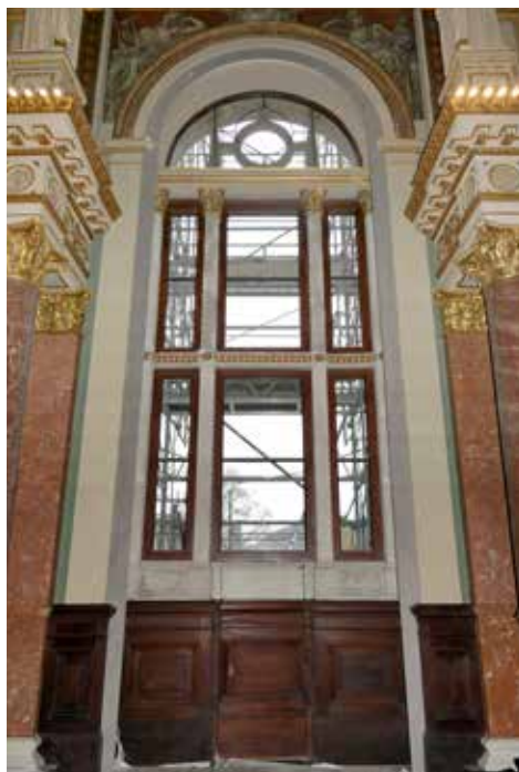
10. kép Felújított ablakegység belső nézete az átadás előtt néhány héttel. A falak festését ezután még javították.
