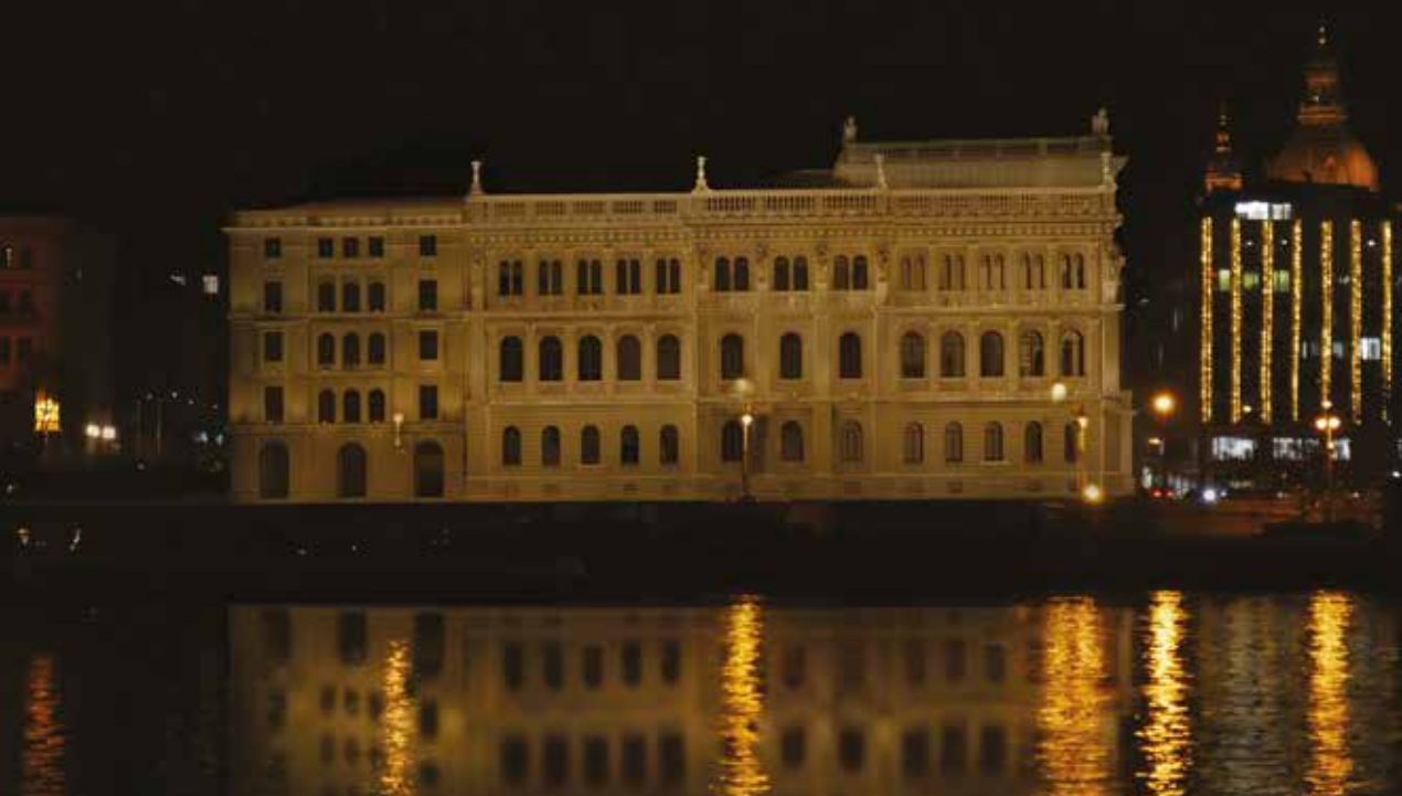
21. kép Díszvilágítás, a felújítás II. üteme után, 2022. (Forrás: Közti Zrt.)
