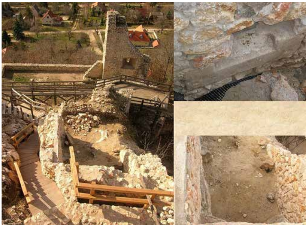
11. kép A kápolna. Bal oldalon a kápolna a feltárás után; jobbra főt: a szentélyablak feltárt könyöklője; jobbra lent: a kápolna szentélye állagvédelem után, a kimozdult jobb oldali diadalív-lábazati elemmel, 2008. (Fotó: Gál Tibor)
