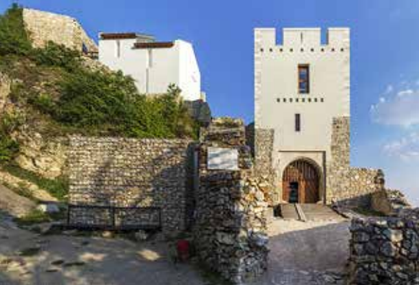
17. kép Északi homlokzat a kaputorony rekonstrukciójának befejezése után, a bal oldalon ún. Gabion-kosaras támfal mögött nyilvános WC-konténer, 2012. (Fotó: Gulyás Attila)
