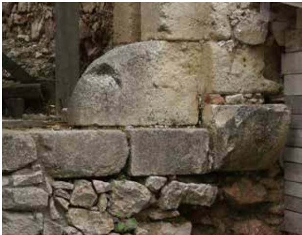
21. kép A kerékvetőtől jobbra a kapu konzolja és alatta küszöbe feltárt, eredeti, építéskori helyzetében, 2008. (Fotó: Gál Tibor)
