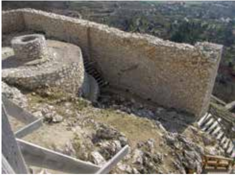
9. kép A felső várudvar a feltöltés előtt, a falon átmenő átereszek és a rekonstruált ciszterna, 2007. (Fotó: Gál Tibor)
