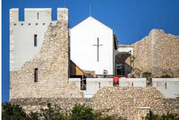
18. kép Nyugati homlokzat a kaputorony rekonstrukciójának befejezése után, a kép közepén látható falmagasítás mögött a pénztár helyisége, a támpillérből közelművek, 2012. (Fotó: Gulyás Attila)
