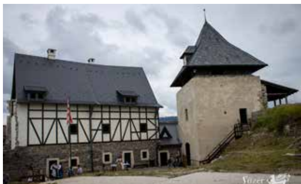
7. kép A 2. ütemben kiépített konyha és sütőház, felettük Fachwerk-szerkezetes emelettel. (Fotó: Füzéri Várgondnokság)
