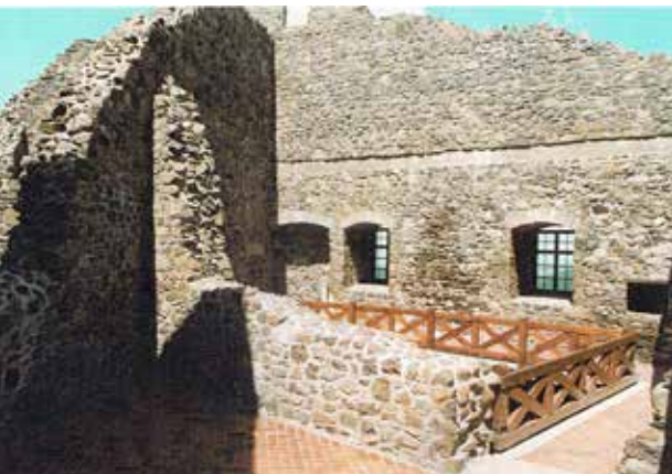
6. kép A nyugati palotaszárnny falának statikai befogása körüljárókkal az eredeti járószinteket jelölve, 28. és 30. jelű helyiségek, 1996. (Fotó: Kremnicsán Ilona)
