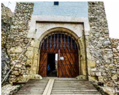
19. kép A kapu-rekonstrukció (a hosszanti két palló ideiglenes), 2012. (Fotó: Gulyás Attila)
