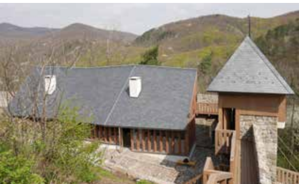
12. kép Kapuépítmény, Várfal-körüljáró és a Fogadóépület, 2024. (Fotó: Skardelli György, Kelemen Bálint Zoltán)
