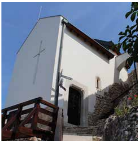
12. kép A kápolna készen: kiegészített középkori ajtó és ablak másodlagos elhelyezésben a déli homlokzaton, 2016. (Fotó: Nagy Gábor)
