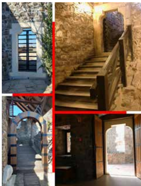
23. képző Kapuk a városban: 17/1. Középső falszoros bejárata; 17/2. Küszöbkövében és szarkövében eredeti gótikus bejárat a felsővár II. szintjére (küszöbköve a +/- 0.00 szint); 17/3. A farkasvermes kapu 15. századi ajtajának jelzése; 17/4. A díszterem bejárata és ablaka új falazatban, 2025. (Fotó: Kremnicsán Ilona)
