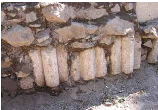
7. kép Az első, 15. századi várkapolna faragott köveit a 16. században beépítették az alsóvári várfal alapozásába, 2015. (Fotó: Skardelli György, Kelemen Bálint Zoltán)
