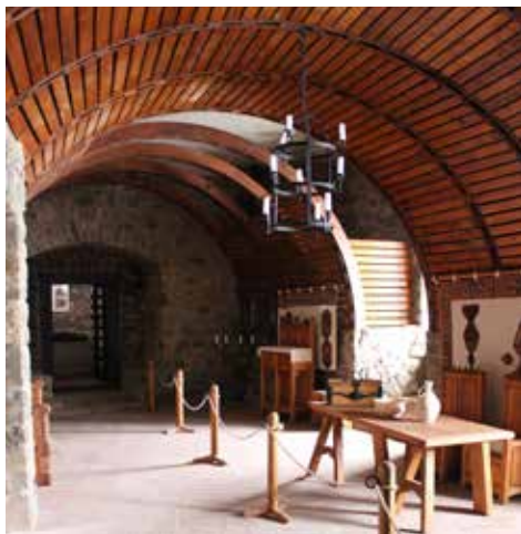
15. kép A palotaszárnny II. szintjének fadongaboltozatos, 18. jelű helyisége. (konyha) (Fotó: Kremncsán Ilona)
