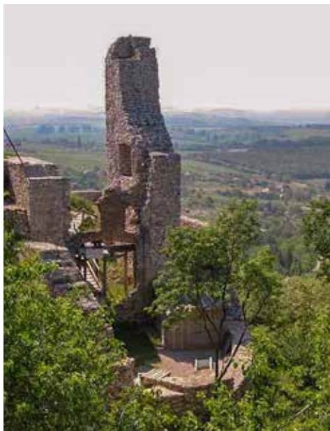
16. kép A kaputorony állagvédelem után, a rekonstrukció előtti állapotban, 2010. (Fotó: Gál Tibor)
