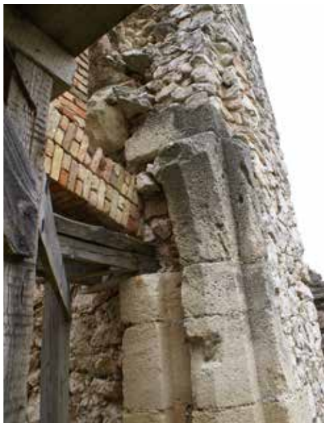
15. kép A kapuszárny és a felvonóhid felső kettős perselyköve, 2008. (Fotó: Gál Tibor)
