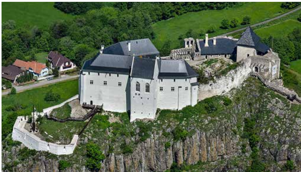
6. kép Füzér, a felsővár a kiépítés első üteme után. (www.civertan.hu)
