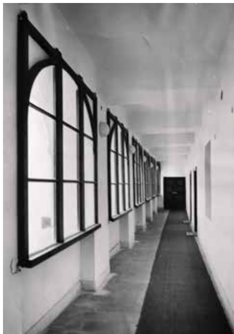
15. kép Déli szárny első emeleti folyosója a leakasztható nyílászárókkal; Dragonits Tamás felvétele, 1965 után (Dragonits Tamás gyűjteménye)
