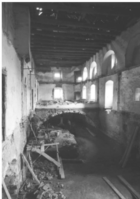
10. kép A déli szárny belseje kelet felé a kivitelezés közben, a födémek elbontását követően Gergelyffy András (?) felvétele, 1961–1965 között (Lelőhely: MÉM MDK Fotótár ltsz. 56533N)
