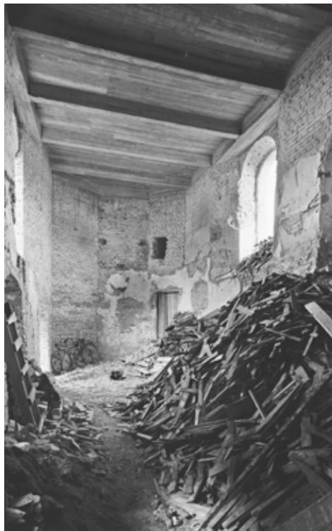
8. kép A keleti szárny (kápolna) belső, dél felőli nézete a kivitelezés közben az új födémrel, Gergelyffy András felvétele, 1961–1965 között (Lelőhely: MÉM MDK Fotótár, Gergelyffy-hagyaték ltsz. 19N)
