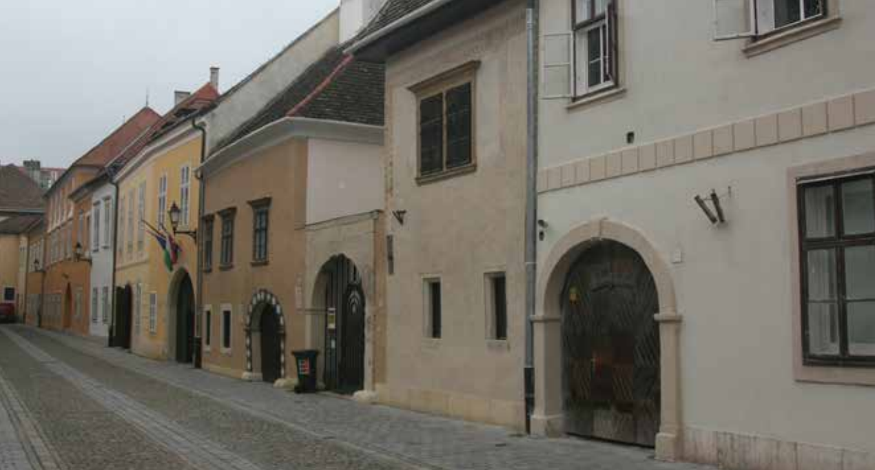
13. kép Az utcai épületszárny emeleti helyiségének elbontása a falazott kapukeretnek köszönhetően nem bontja meg az utca zárt sorú beépítését, 2024. (Fotó: Józsa Dávid, Veöreös András)
