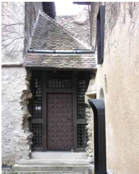
10. kép A zsinagóga főbejárata. A nyílás pontos helyzete és mérete ismeretlen, ezért itt a fal töredékes kibontása és kortárs portál jelenik meg, 2024. (Fotó: Józsa Dávid, Veöreös András)
