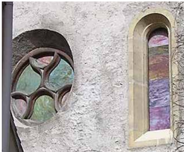
14. kép A rózsablak körtefából készült „mér műve” és a 19. századi ablak helyén rekonstruált ablak, 2024. (Fotó: Józsa Dávid, Veöreös András)
