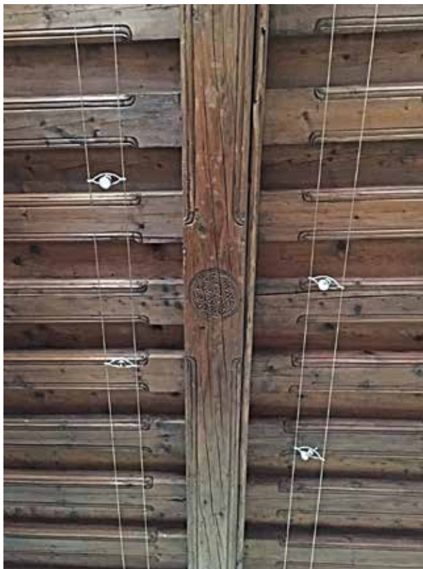
11. kép Faragott sűrűgerendás fafödém az első emeleti tiszta szobában, 2024. (Tárkányi Sándor felvétele)
