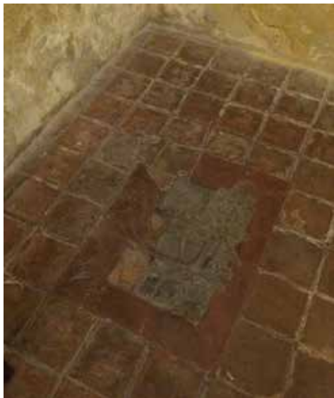
9. kép A padló szintje és kialakítása a fellelt eredeti téglaburkolathoz igazodik, 2024. (Fotó: Józsa Dávid, Veöreös András)
