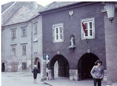
8. kép A Kolostor u. 13. számú épület felújítás előtti képe 1973-ban. (Forrás: Fortepan / Majercsik Tamás)
