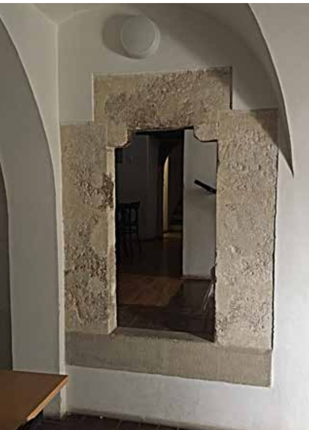
13. kép A későromán lakótorony helyreállított vállköves első emeleti bejárata, 2024. (Tárkányi Sándor felvétele)
