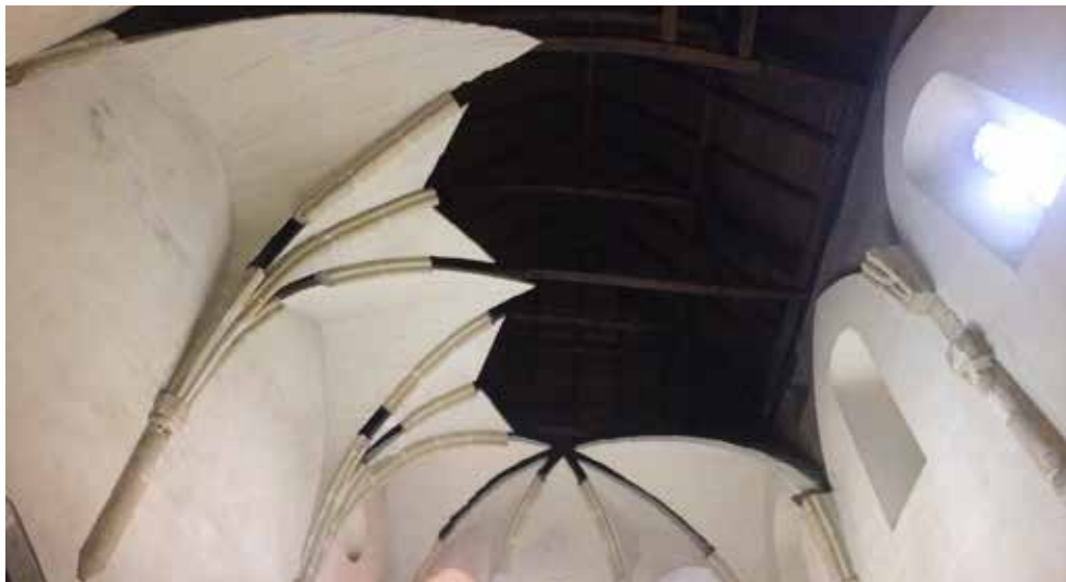
7. kép Az elpusztult boltozat formáját idézik a falból konzolosan kiálló meszelt vasbeton héjak. A formát a héjak között elhelyezett eredeti és rekonstruált bordadarabok hitelesítik, 2024. (Fotó: Józsa Dávid, Veöreös András)
