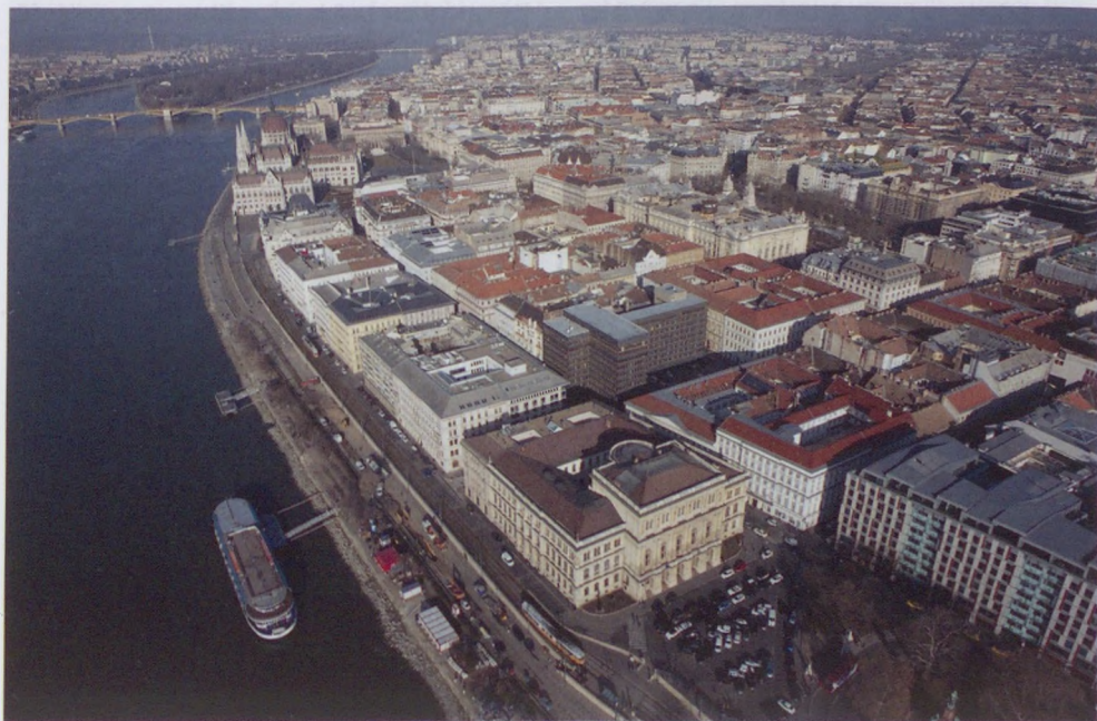
5. kép Székház és könyvtár a felújítás előtt, 2022. (Forrás: Közti Zrt.)
