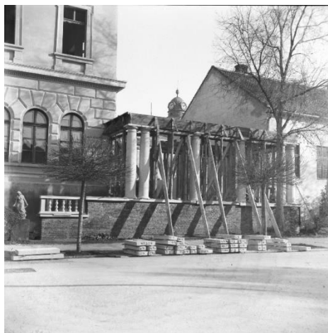
A zenepavilon építése – 1939 83
