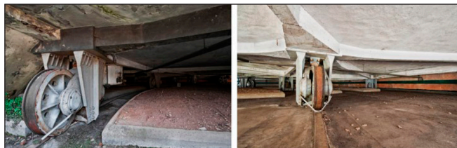
20. ábra: A Villa Girasole forgó rendszerének kerekei
