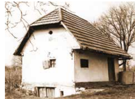
4. kép: Borospince a szőlőhegyen, Hegyszentmárton. Zentai János szerint az utolsó talpas épület, teteje már átcserépezve. Mélyszerint a présház, abból nyílik még egy szinttel mélyebbre a pincelyuk. (Fotó: Zentai János 1972., JPM NO 29267)
