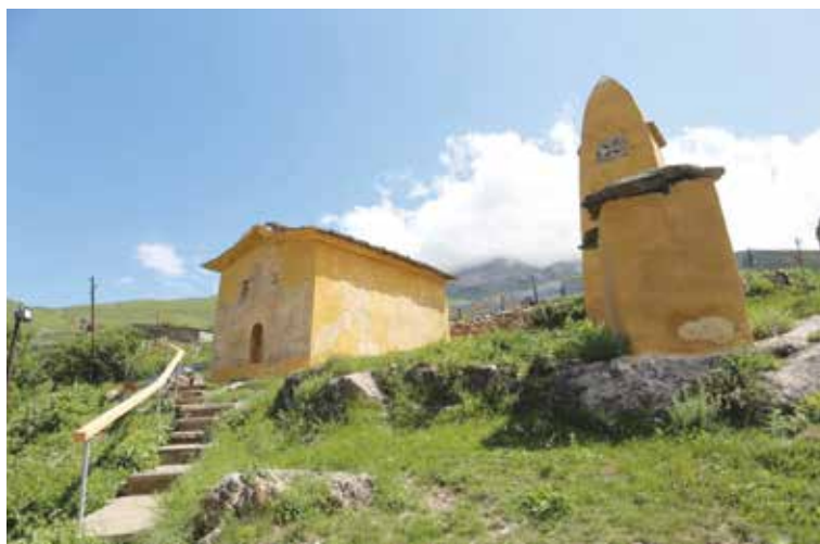
A faraskattai Illés templom a felújítás után
