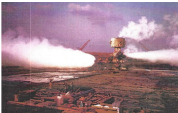
4. ábra. A gőzkiáramlás a kitörésgátló csere után és a lyukmegelőzés előtt
