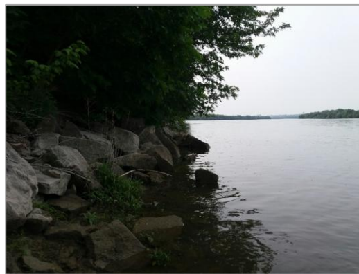
2. fotó. A partvédelmi kőszórás a Gudmon-foki kútsor előtt (Csiszár 2019)
