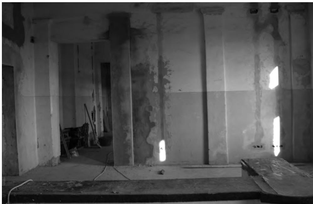
Városháza, aula felújítás alatt
