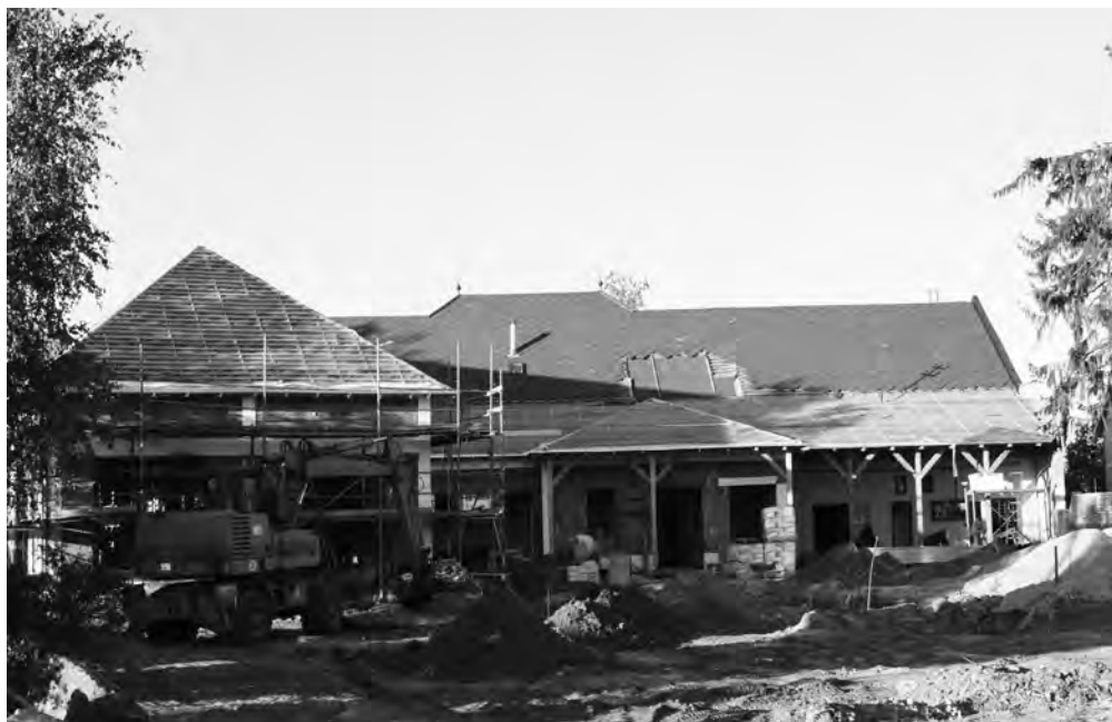
Kaszinó hátsó homlokzatépítés alatt
