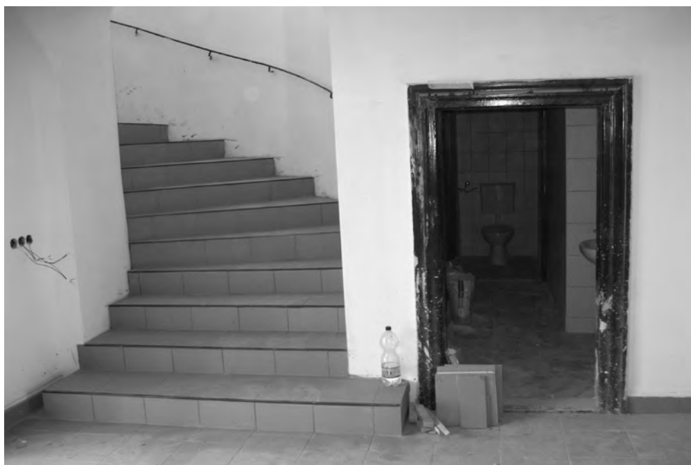
Városháza, az egykori fogda bejárata
