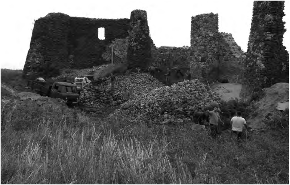
A keleti várfalnál folyó munkálatok 2008 őszén
