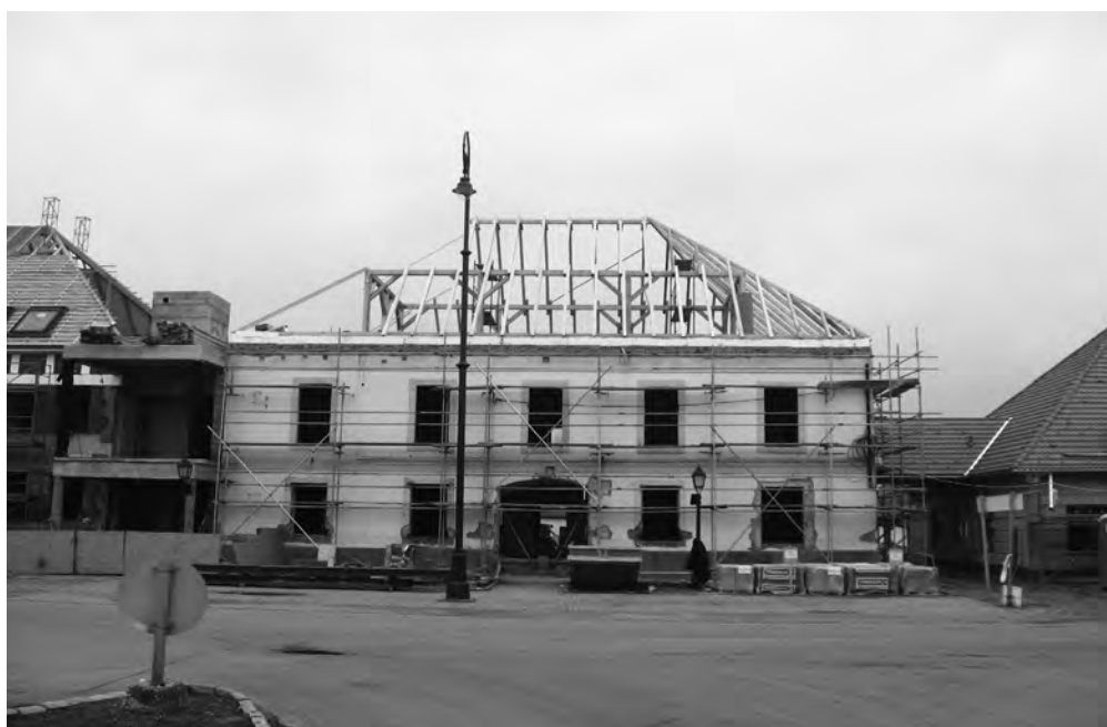
Épül a tető
