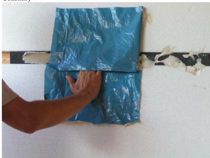
2. ábra. A denevérek kijutását biztosító ideiglenes lezárás modellje. A fehér hablemezből kialakított felület egy panelépület falát, a ragasztóval bekent szürke rész a már tömedékelt panelhézagot jelképezi. (fotó: Császár Zsolt)
