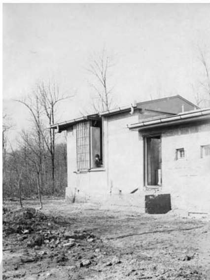
Az épülő passzázsház 1922-ben, nyitott tetővel (kép: MTA KIK Kézirattár)
