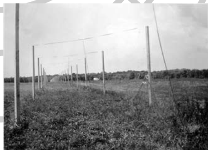
A Mills Cross Array, Burke és Franklin antennarendszere (Archives of the Carnegie Institution of Washington)
