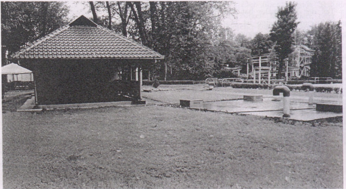
Abb. 22. Schutzbau über einer römischen Quellenfassung
