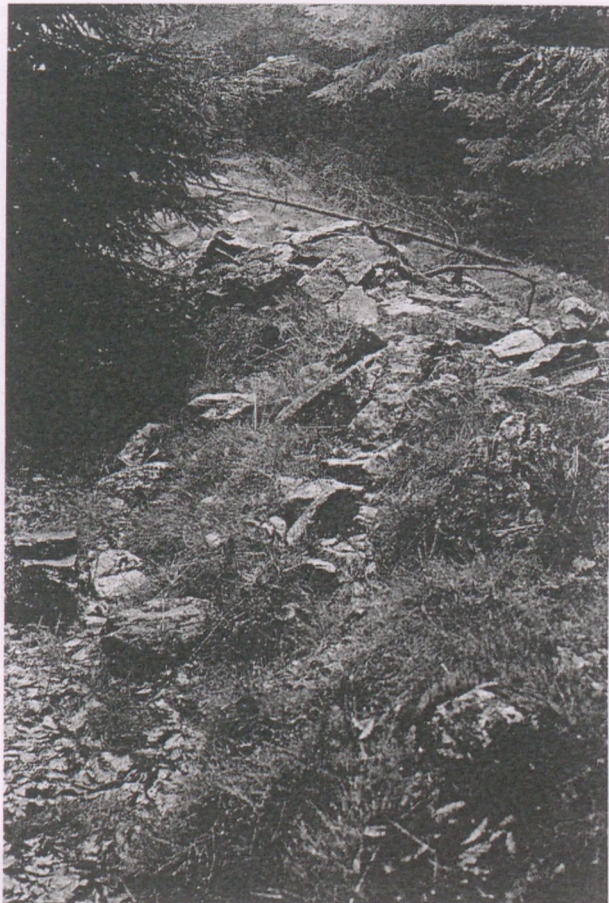
Abb. 2. Bad Homburg v.d.H., Hochtaunuskreis. Versturz der Limesmauer zwischen den Wachtposten WP 3/59 und 3/60 (Aufnahme: Landesamt für Denkmalpflege Hessen)
