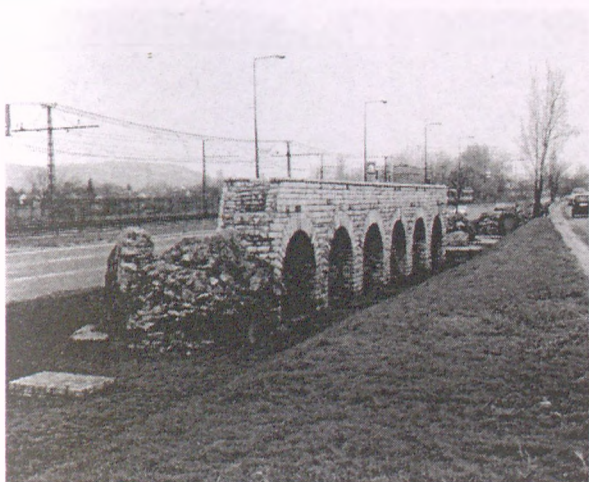
Abb. 9. Rekonstruierte Strecke der Wasserleitung
