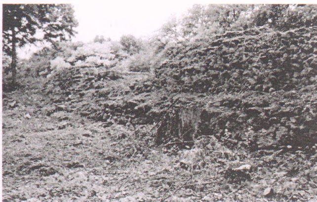
Abb. 20. Szigetmonostor – Horány Zustand der römischen Villa 2007, von der Donau aus gesehen
