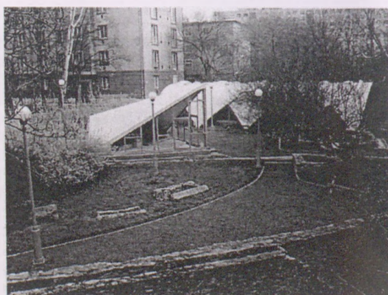
Abb. 14. Schutzgebäude über die Mauerreste und Mosaiken in Museum Hercules Villa
