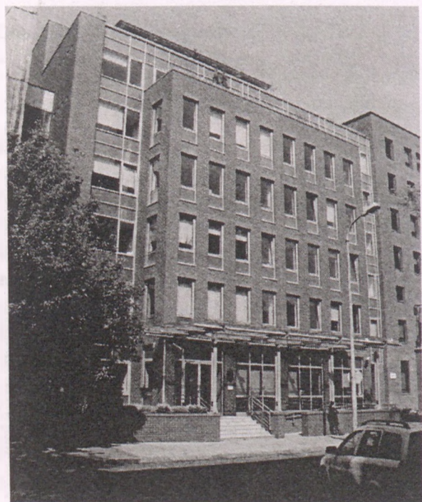
Abb. 32. Neues Gebäude des Aussenministeriums (Nagy I. Platz 4/Gyorskocsi Str. 26. = Fo 19)
