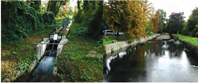
2-3. ábra | A Hévíz-tó kifolyócsatornái, az északi és a déli zsilip (Forrás: saját fotó 2022.)
