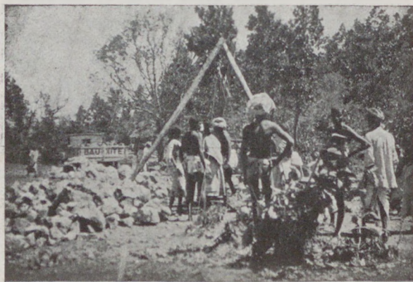
6. ábra. Bauxit átvetele Bagru hegy lábánál. A bauxitot hatalmas ingamérleggen mérik és teherautóval 8 km.-re lévő vasutállomásra szállítják.
