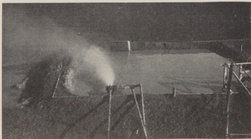
6. ábra. Az Eurogasco lispei I-ső számú mélyfúrásának 1066—1085 méter mélységéből feltárt olajos földgáz. Dr. Papp Simon felvétele.
