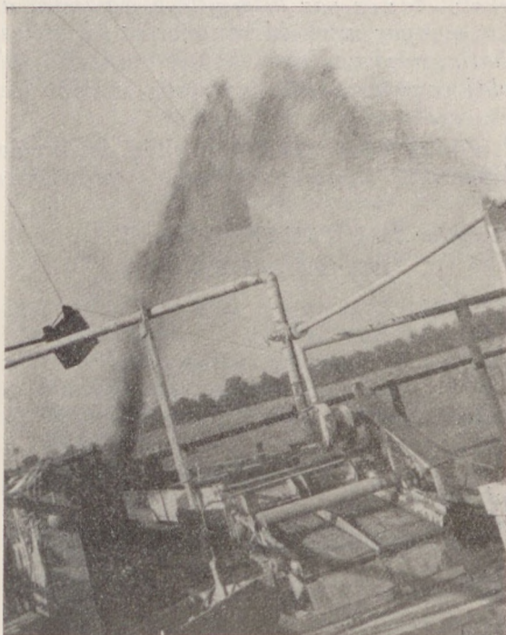
3. ábra. Fűróiszap, szénsav és metángáz kitörés az Eurogasco ilhurosberényi, Somogy m. mélyfurásából. Fot. dr. Papp Simon.
