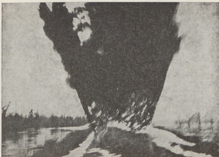
6. ábra. Arvédelmi gát felrobbantása a New Madrid árapasztó üzembehelyezéséhez (1937. február).
