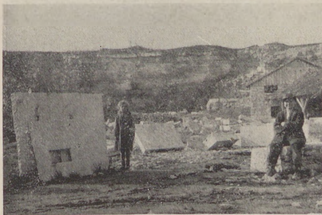
27. ábra. Budakalászi forrásvízi mészkőbánya. Az előtérben fűrészelt falburkoló lemezek láthatók. Dr. Kőrössy L. fényképe.
