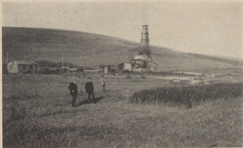
51. ábra. A III. számú fúrás Nagysármáson 330 m. t. f. magasságú térszínen. A fúrás 974 m mélységben végződött. Dr. Papp Károly felvétele 1910 június 28-án.
