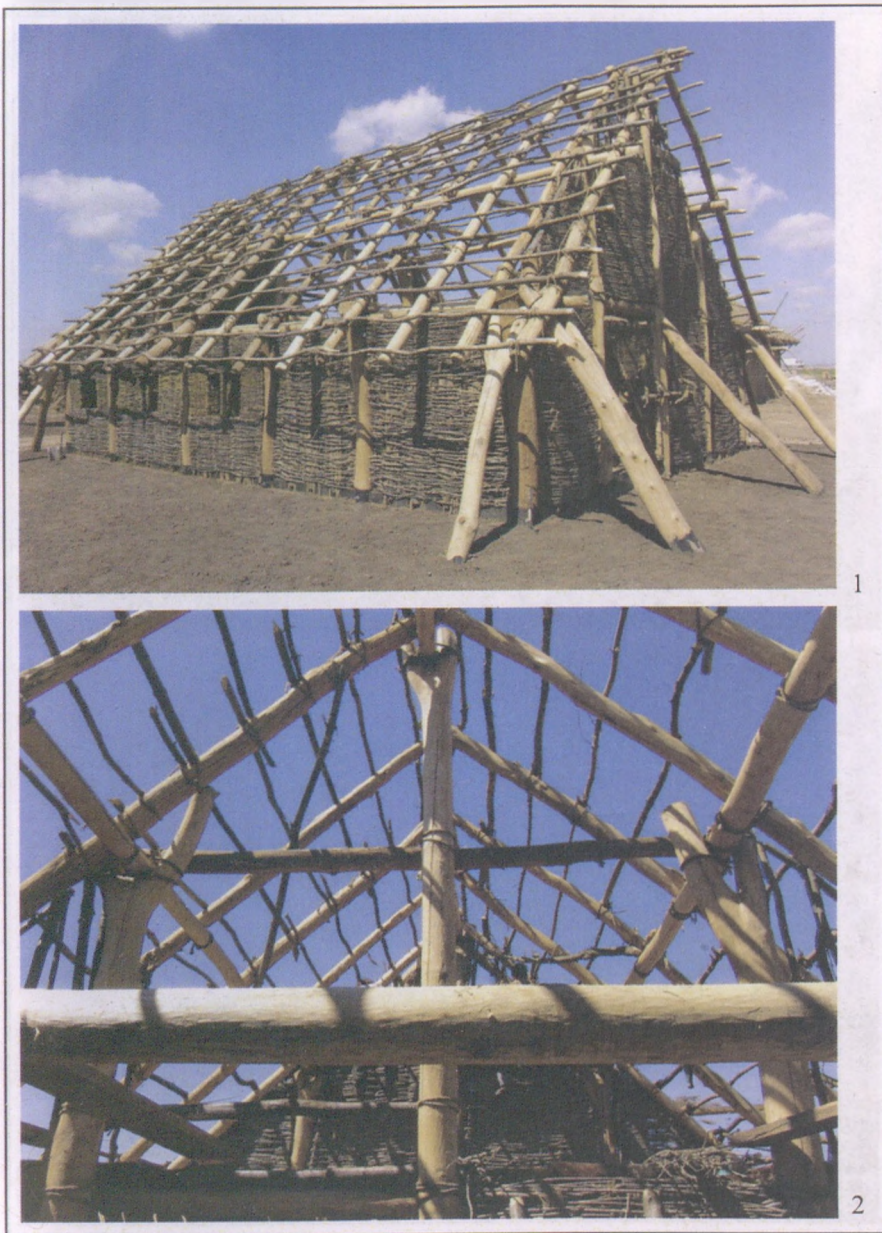
6. kép. M3 Archeopark (Polgár) — 1–2: a ház építés közben Fig. 6. M3 Archeopark (Polgár) — 1–2: the building during its construction
