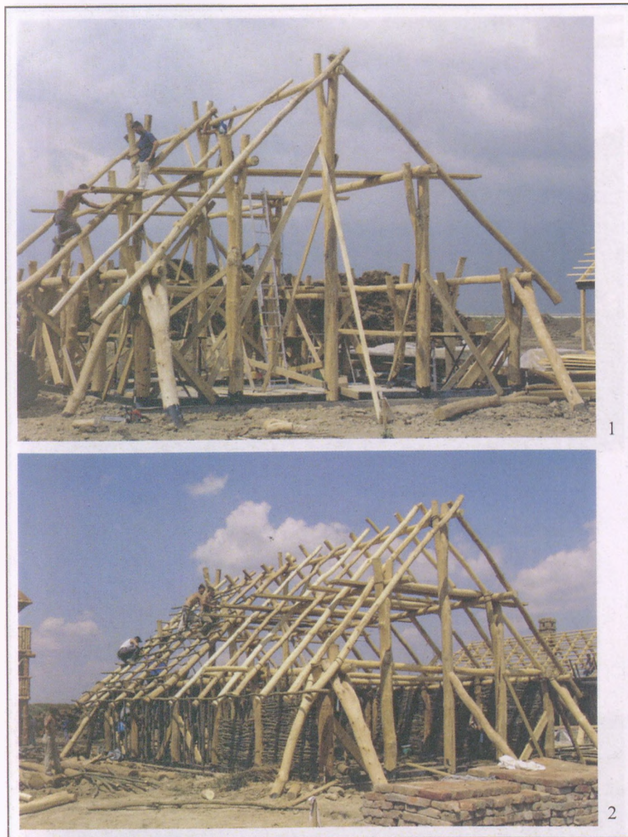
4. kép. M3 Archeopark (Polgár) — 1–2: a ház építés közben Fig. 4. M3 Archeopark (Polgár) — 1–2: the building during its construction
