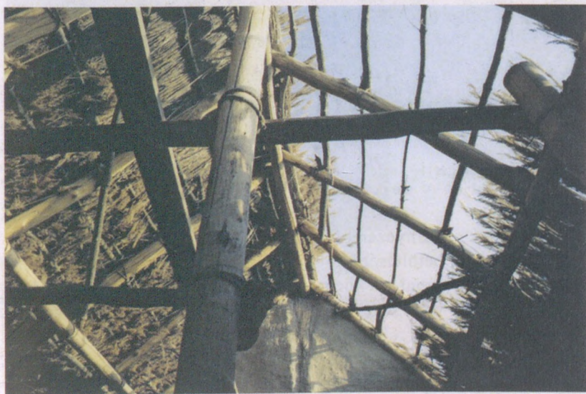
8. kép. M3 Archacopark (Polgár) — a ház építés közben Fig. 8. M3 Archacopark (Polgár) — the building during its construction
