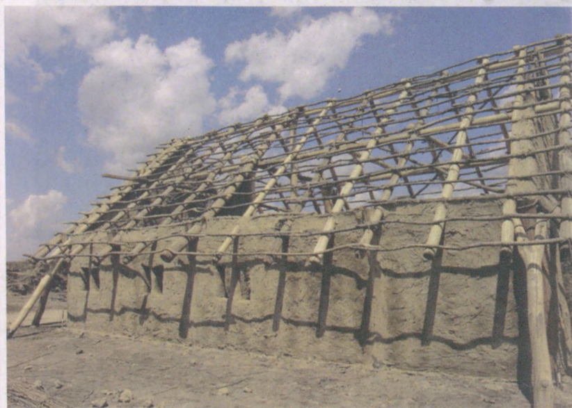
7. kép. M3 Archeopark (Polgár) — 1–2: a ház építés közben Fig. 7. M3 Archeopark (Polgár) — 1–2: the building during its construction
