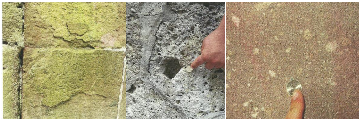
10. ábra: Az avasi templomhoz, a környékbeli épületekhez és pincékhez tömegesen felhasznált bükkaljai és bodrogkeresztúri riolituffa egyes változatai a fagy- és vízhatásnak kevésbé állnak ellent, amit az idomkövek sarkainak és oldalainak felületi hámlása jelez. Az erősen összesült, vöröses színű bükkaljai dácittufák (jobbra) ellenállóbbak.
