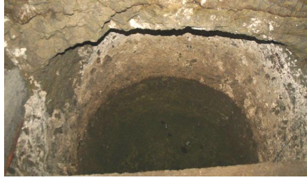
16. ábra: A kútszerű fenéksomp a mélyebb helyzetű második pincszakaszban mélyült a beszivárgott csapadékvizek összegyűjtése céljából
