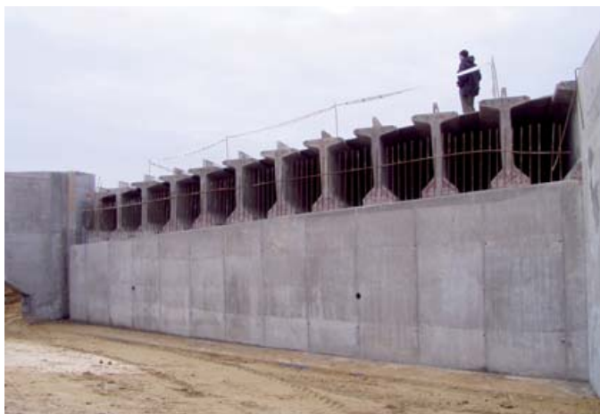
1. kép: A FI 150/44,8-as előregyártott, előfeszített vasbeton híderendák a Z-15. sz. felüljáró készítése közben
