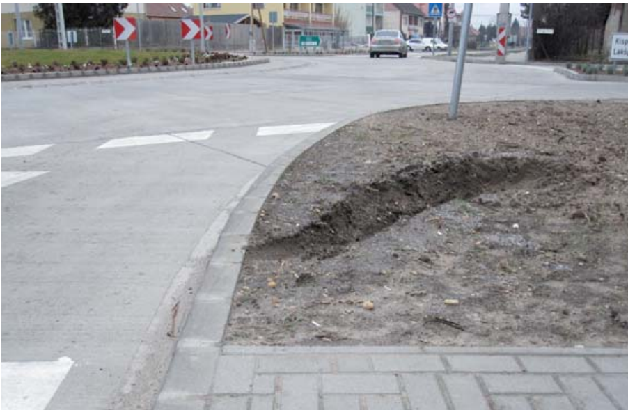
1. kép: A szegélyre történt ráhajtas nyomai
