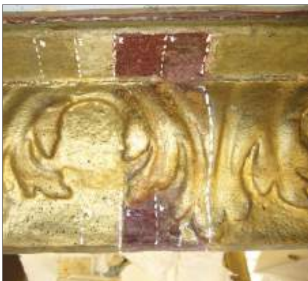
7. kép: Párkány átfestésének rétegei
