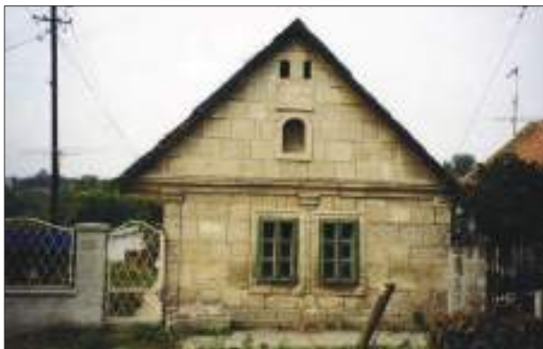
3. kép: Kváderkövekből épített lakóház Sósúton, 1899
