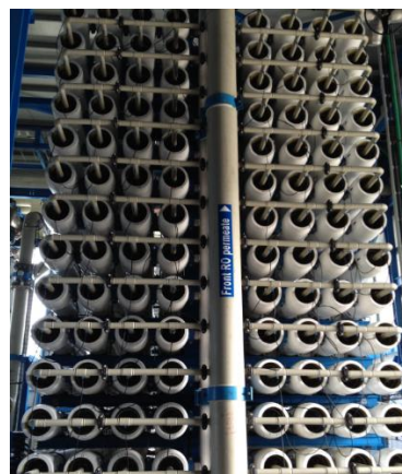
Sótalanításban használt ipari méretű UF és RO membrán modulok (az üzemlátogatások során készített saját fényképek)
