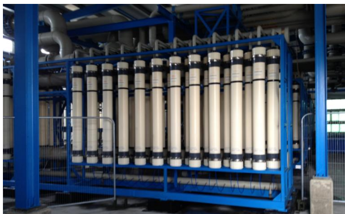
Sótalanításban használt ipari méretű UF és RO membrán modulok (az üzemlátogatások során készített saját fényképek)
