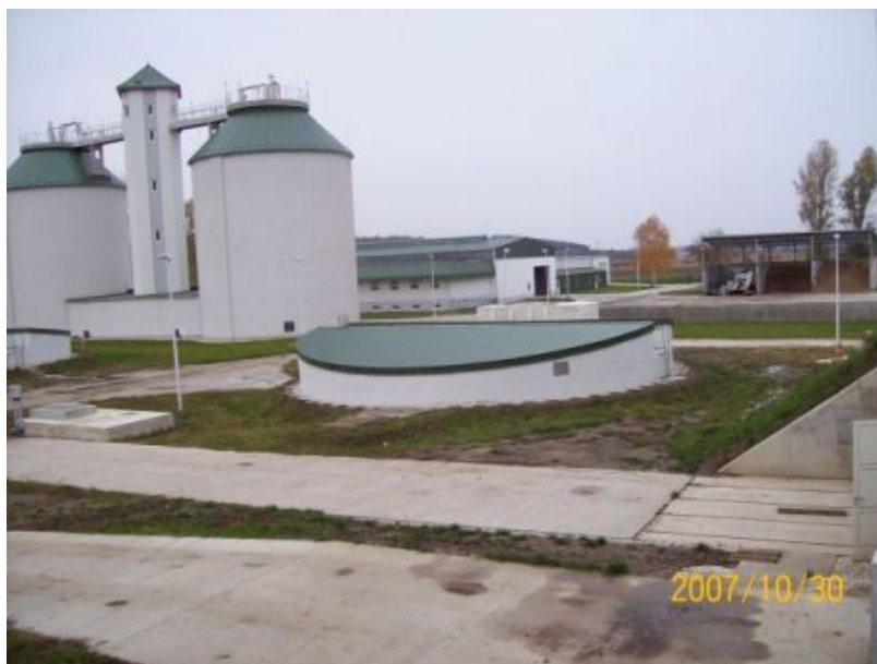
1. ábra: Biogáz üzem az anaerob rothasztó tornyokkal
