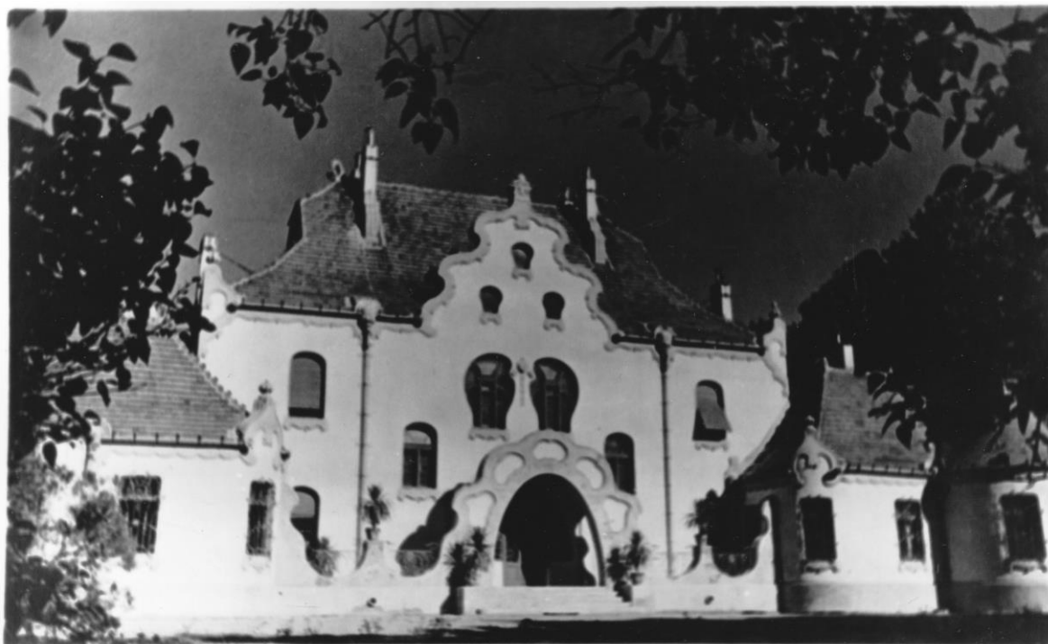
11. A kastély főhomlokzata, fénykép. MÉM-MDK Ltsz:17.012
