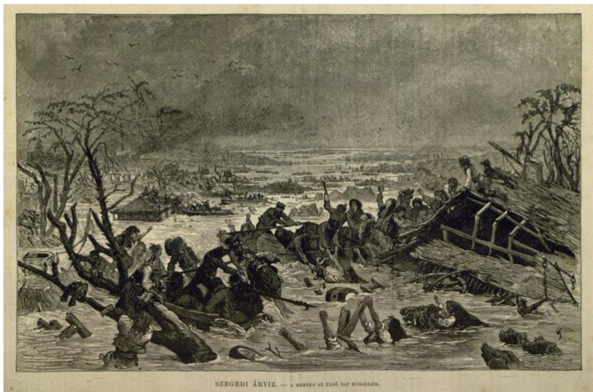
4. Árvízi jelenet – Szeged. Vasárnapi Ujság, 1879. ápr. 13.
