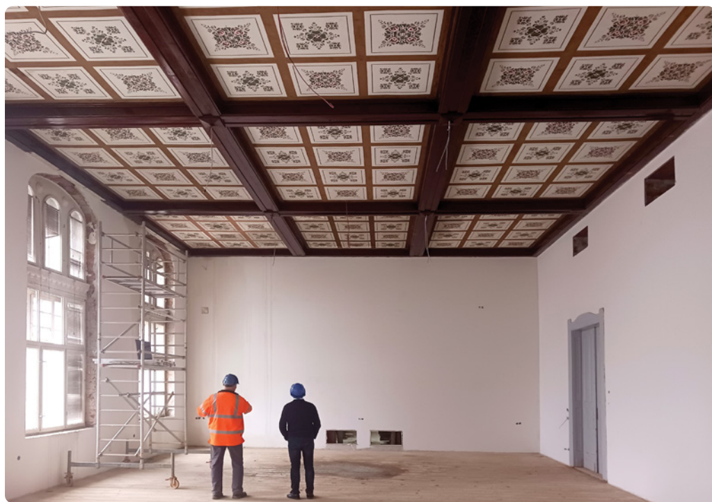
A díszterem festett kazettás mennyezete a rekonstrukció közben
