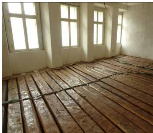
■ Fig. 26. Planșeu planar, unitar, vizibil în întreaga încăpăre de la etaj, suprapusă peste cele două spații distincte de la parter. © Georgiana TIRT ■ Fig. 26. Uniform plane slab, visible throughout the upstairs space, placed above the two separate ground floor spaces. © Georgiana TIRT
