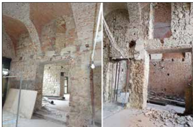
■ Fig. 44. Încăperile P6-P7, cele mai afectate de modificarea golurilor în pereți. © Georgiana TIRT ■ Fig. 44. Rooms P6-P7, most affected by the changes in wall openings. © Georgiana TIRT
