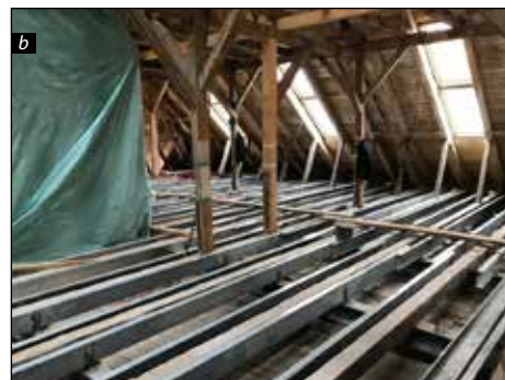
■ Fig. 39. Montarea grinzilor principale (sus) și cele secundare (jos) ale planșeului mansardei. © Georgiana TIRT
