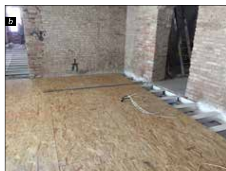
■ Fig. 35.a, b. Structura metalică a podinei de la etaj, în încăperea E6 (stânga) și în plan secund E5 (dreapta). © Georgiana TIRT
