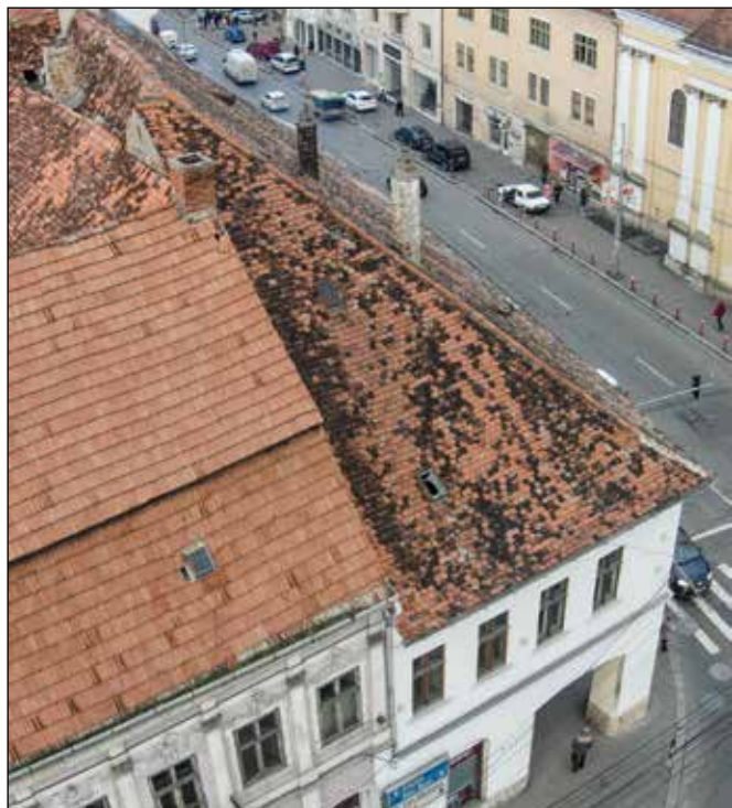
■ Fig. 7. Acoperiș, vedere sudică. © Virgil POP ■ Fig. 7. The roof, South view. © Virgil POP
