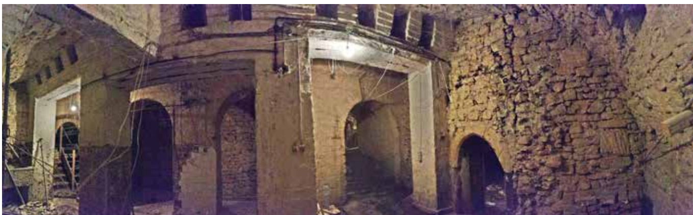
■ Fig. 22. Consolidarea bolții peste subsol, în încăperea centrală (în prim plan cea din sec. XX, în plan secund cea din sec. XIX). © Georgiana TIRT ■ Fig. 22. Reinforcement of the vault above the basement, in the central hall (20 th century vault in the foreground, 19 th century vault in the background). © Georgiana TIRT
