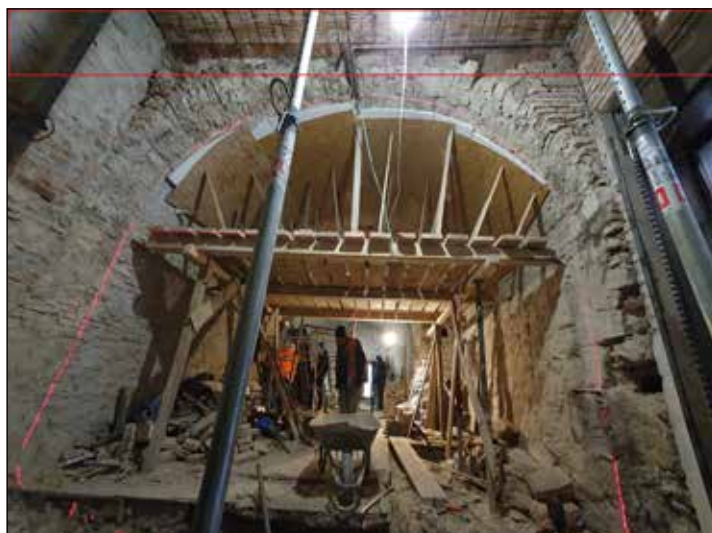
■ Fig. 25. Desfacerea peretelui. În partea superioară a fotografiei sunt vizibile capetele grinzilor de lemn. © Georgiana TIRT ■ Fig. 25. Deconstruction of the wall. The ends of the timber beams are visible at the top of the photo. © Georgiana TIRT
