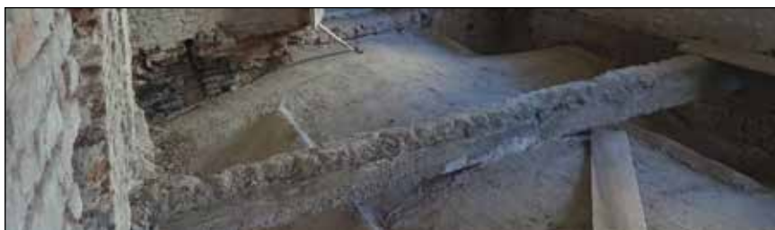
■ Fig. 36. Grindă de rigidizare, din beton armat amplasată în zona mediană a planșeului peste încăperea P5. © Georgiana TIRT
