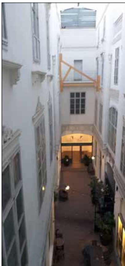
■ Fig. 3. c ábra. Ideiglenes megerősítés kívülről, a beszakadt részen. © MÉSZÁROS Bernadett ■ Fig. 3. c Provisory reinforcement from the outside of the part affected by the collapse. © Bernadett MÉSZÁROS
