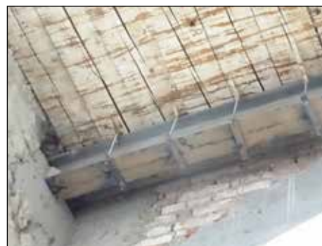
■ Fig. 33. Rezemarea grinzilor de lemn ale planșeului peste parter, pe o grindă metalică. © Georgiana TIRT
