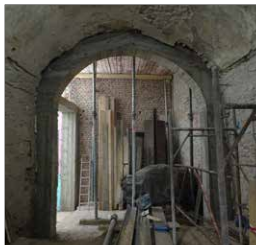
■ Fig. 32. Arc de beton armat. © Georgiana TIRT
