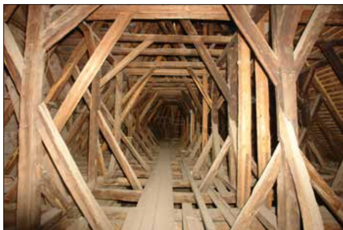
■ Fig. 72. Târgu Mureș, Biserica reformată, podul gotic al corului. © Virgil POP ■ Fig. 72. Târgu Mureș, Calvinist Church, Gothic attic of the choir. © Virgil POP
