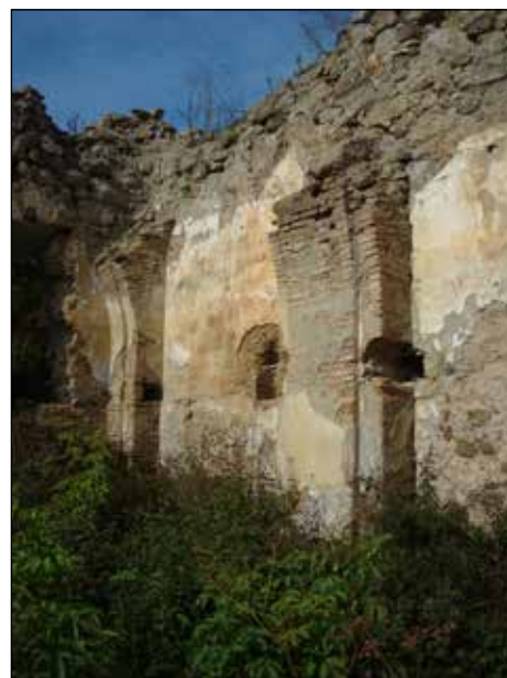
■ Fig. 46. Jelna, Biserica evanghelică, interior cu pilastru și arc de susținere a calotei, 2004. © Virgil POP ■ Fig. 46. Jelna, Lutheran Church, interior with pilaster and supporting arch of the vault, 2004. © Virgil POP
