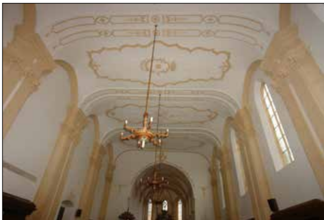
■ Fig. 74. Târgu Mureș, Biserica reformată, interior navă cu pilaștri baroci. © Virgil POP
