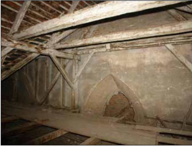
■ Fig. 21. Sibiu, Biserica ursulinelor, fereastra gotică obturată din fațada sudică, văzută din podul mănăstirii. © Virgil POP
