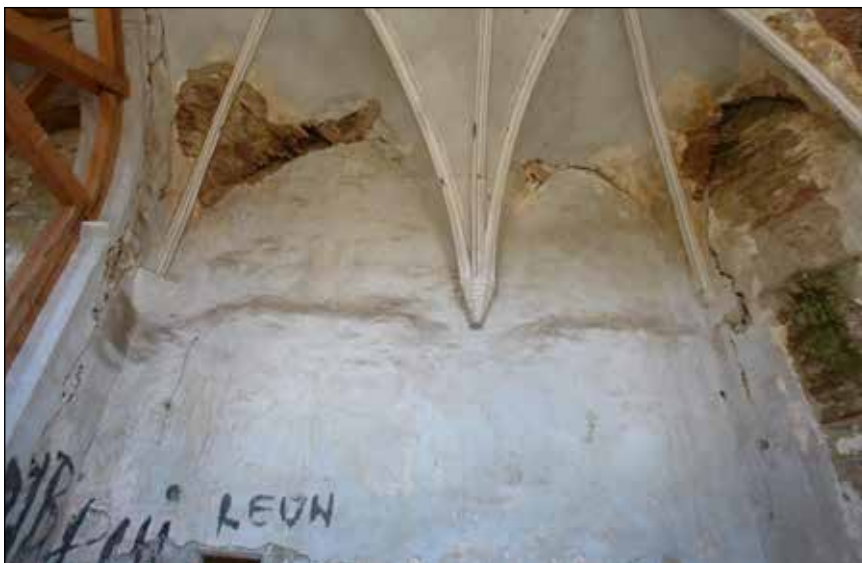
■ Fig. 52. Vermeș, Biserica evanghelică, traveea dreptunghiulară cu console în piramidă întoarsă. © Virgil POP
