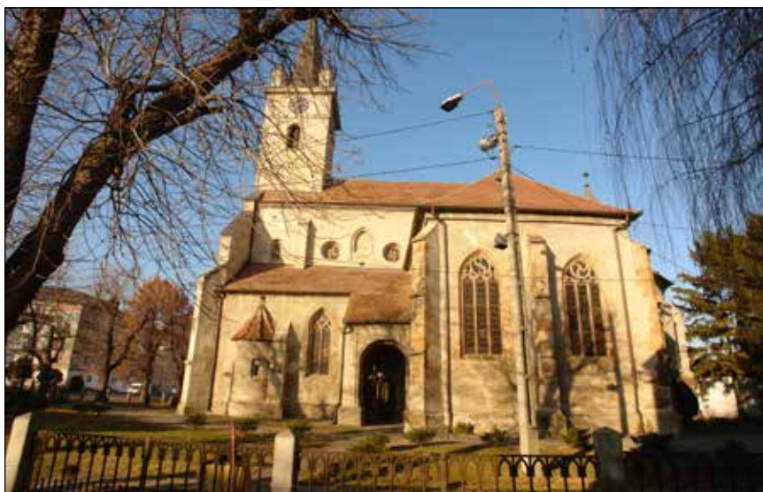
■ Fig. 63. Reghin, Biserica evanghelică, fațada sudică cu capela adăugată în sec. XV. © Virgil POP ■ Fig. 63. Reghin, Lutheran Church, southern elevation with chapel added in the 15 th century. © Virgil POP
