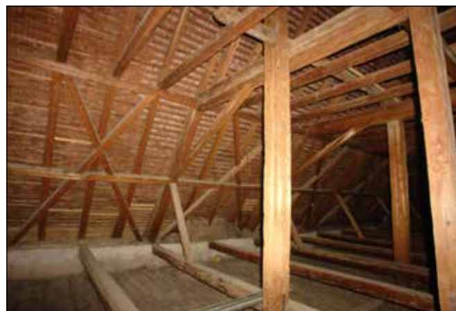
■ Fig. 73. Târgu Mureș, Biserica reformată, podul baroc al navei. © Virgil POP ■ Fig. 73. Târgu Mureș, Calvinist Church, Baroque attic of the nave. © Virgil POP
