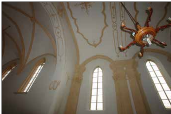
■ Fig. 75. Târgu Mureș, Biserica reformată, unitatea de stil în decorație impune folosirea arcului frânt și la arhivolta barocă. © Virgil POP
