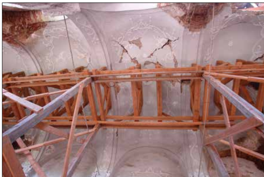
■ Fig. 53. Vermeș, Biserica evanghelică, bolta navei cu stucatură rococo. © Virgil POP ■ Fig. 53. Vermeș, Lutheran Church, nave vault with Rococo stucco. © Virgil POP
