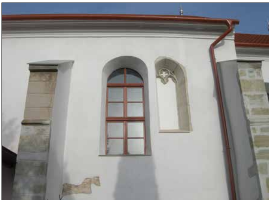
■ Fig. 42. Ciceu-Mihăiești, Biserica reformată, fereastra semicirculară introdusă de „restaurarea” barocă și fereastra gotică readusă la suprafață de restaurarea din secolul XX. © Virgil POP
