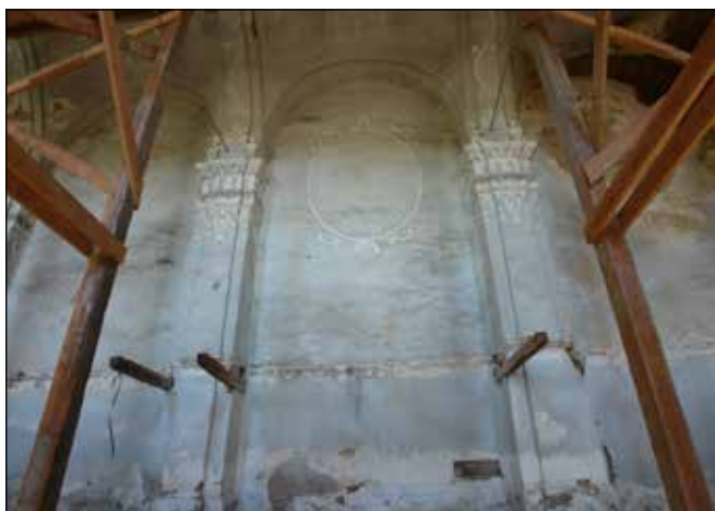
■ Fig. 54. Vermeș, Biserica evanghelică, peretele nordic după desfacerea tribunei laterale. © Virgil POP
