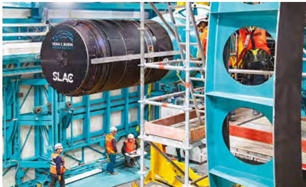
2. ábra. A Vera C. Rubin Observatórium munkatársai az LSST-kamera beszerelése közben 2015 márciusában. A kamera a sötét, autó méretű henger a kép közepén. Forrás: RubinObs/NOIRLab/SLAC/NSF/DOE/AURA/B. Quint
