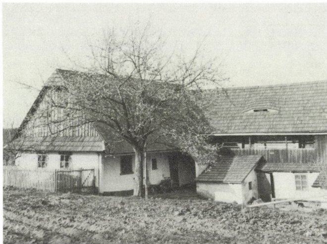
Abb. 4. Getünchtes Bauernblockhaus mit Simsdach und Schopfdächlein in Ostböhmen aus dem 18. Jahrhundert. Veselý Kopec Nr. 4, Kreis Chrudim . Foto J. Váreka, 1975
