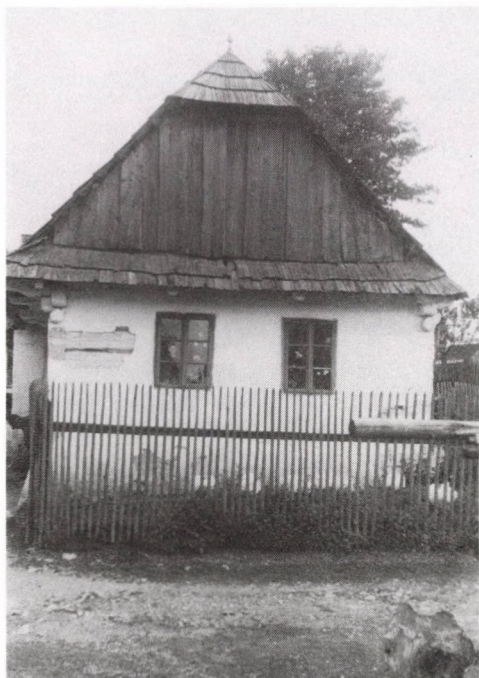
Abb. 6. Giebelstirnseite der Blockhütte mit Simsdach und Schopfdächlein in Ostböhmen von der Wende des 18. und 19. Jahrhunderts. Slavětín Nr. 10, Kreis Havlickův Brod . Foto V. Kubásta, 1942
