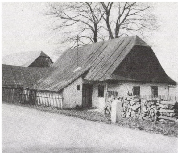
Abb. 5. Getünchtes Blockhaus mit Simsdach vom Karpatentyp in Ostböhmen von der Wende des 18. und 19. Jahrhunderts. Kamenický Nr. 35, Kreis Chrudim . Foto J. Váreka, 1972
