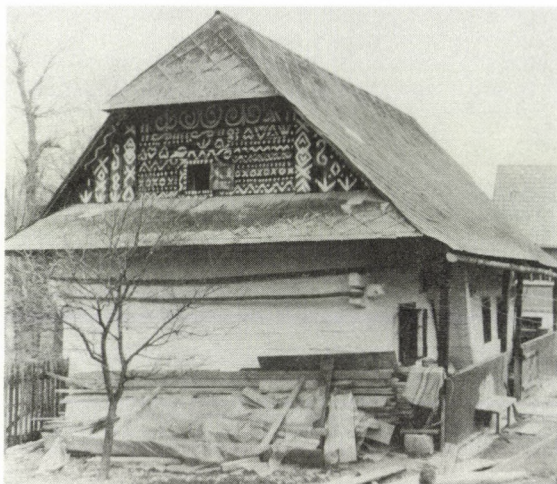
Abb. 2. Getünchtes Haus mit Blockhauskammer in der Dachkonstruktion. Čičmany, Nr. 216, Kreis Žilina . Foto J. Váreka, 1981
