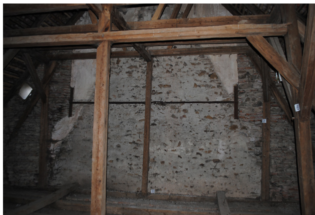
7. A régi fedélszék lenyomata a torony északkeleti oldalán (a szerző felv.) / The cast of the old roof on the north-eastern side of the tower (photo by the author)
