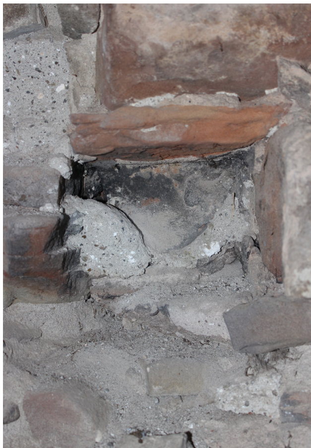
5. Égésnyom a torony egyik gerendafészkében (a szerző felv.) / Burning reminiscence in a beam's pocket of the tower (photo by the author)
