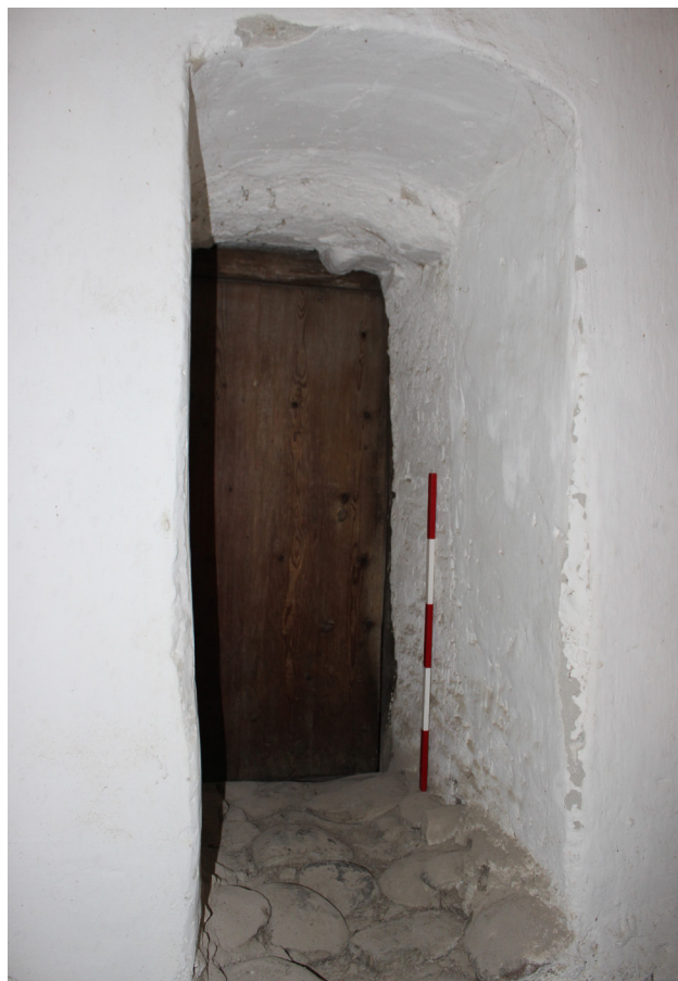
6. A torony és a templomhajó falazatának kapcsolata a nyugati karzatról (a szerző felv.) / The join between the tower and the nave of the church from the western gallery (photo by the author)
