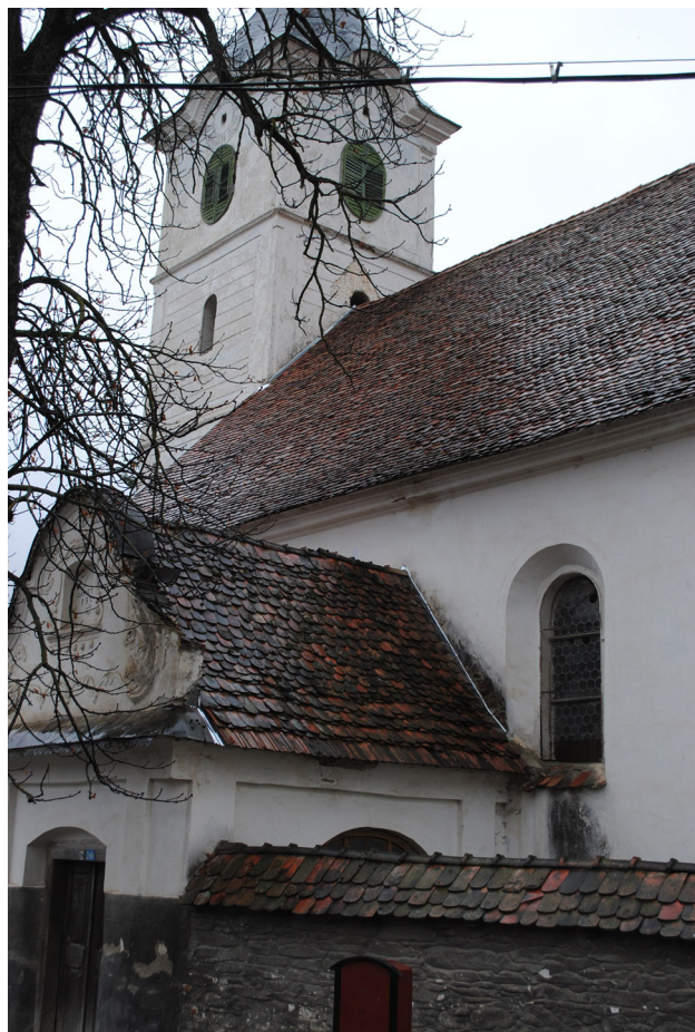
4. A templom tornya keletről, a régi fedélszék fölötti ablakkal (a szerző felv.) / The church's tower from east, with the window above the old roof (photo by the author)
