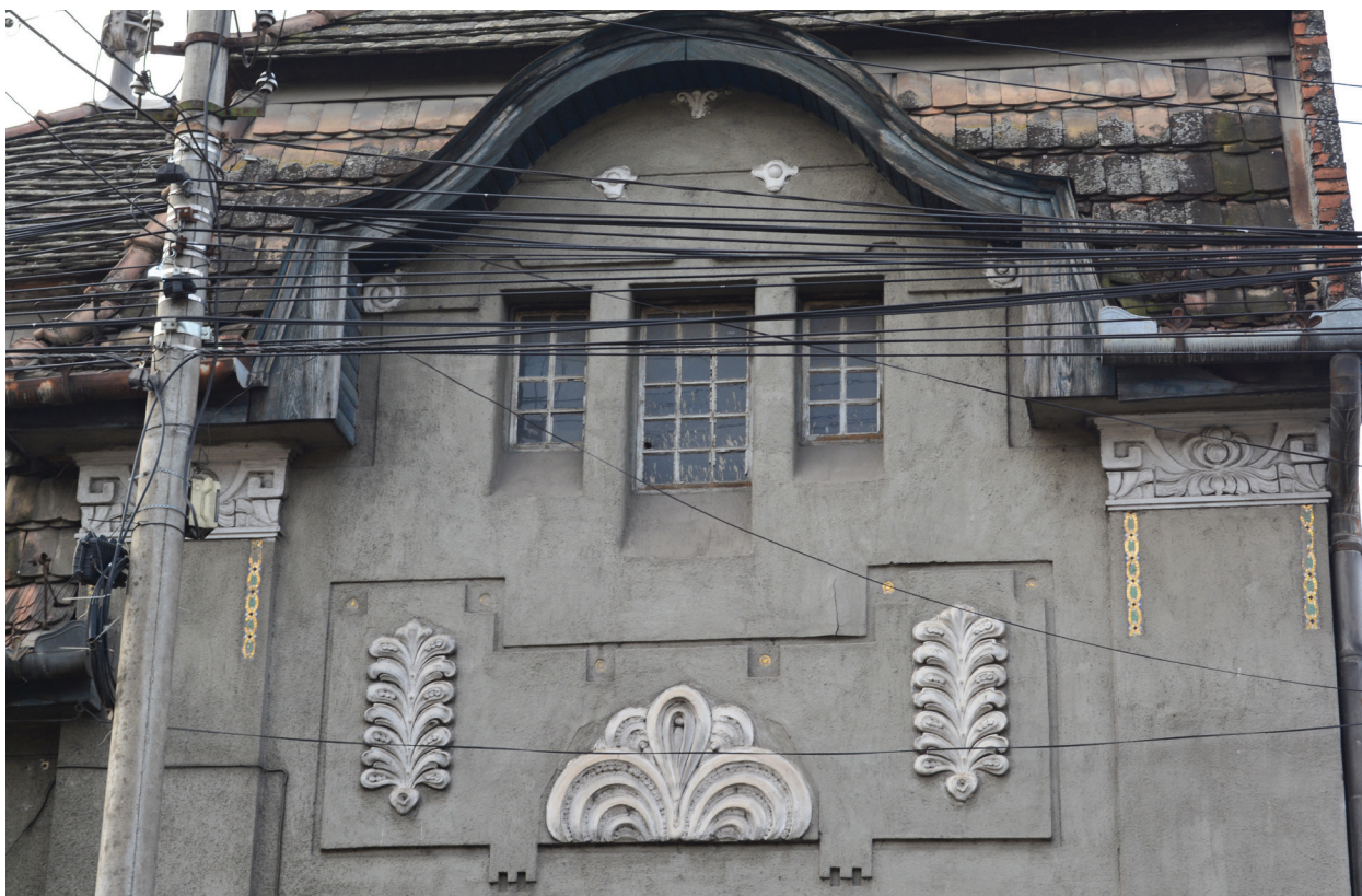
23. Bíró Ármin házának homlokzati részlete / Detail of the main façade from Ármin Bíró's house
