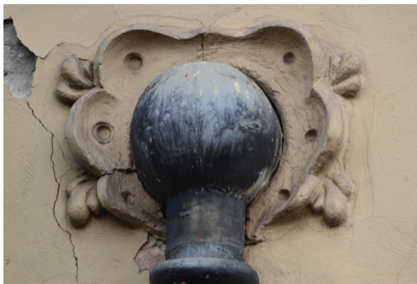
8. Csatornaüst Marosi Cuza Vodă 34. sz. alatti házának főhomlokzatán / Detail of the main façade from Marosi's house, 34 Cuza Vodă Street
