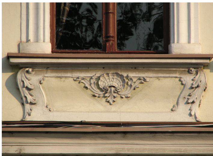
18. Ablakkötény az emeleten, 2013 / Upstairs window apron, 2013
