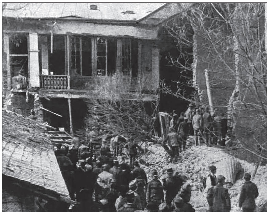
10. kép. A robbanás, az udvar felőli látvány, 1917. Forrás: Vasárnapi Újság
