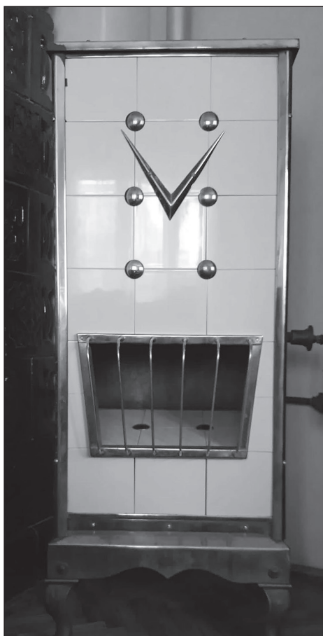
7. kép. Gázfűtésre átalált kályha. Szerző felvétele, 2022
