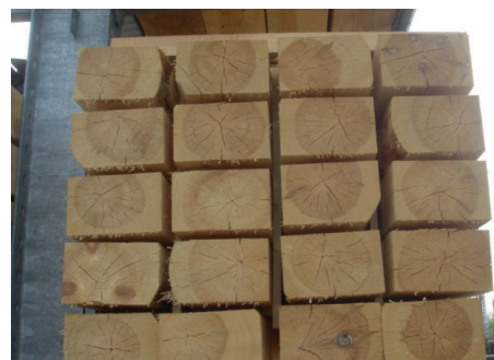
2. ábra: Elfogadható száradási repedések a keresztmetszeten
