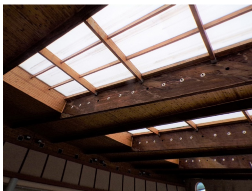
24. ábra: Mérés ArborSonic 3D-vel az egyik főtartón
