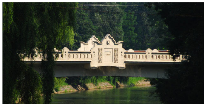
Temesvár, Liget úti Bega híd [1]
