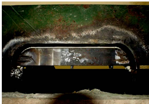
18. ábra A kivágott rész helyére beillesztett 70mm vastag pótlemez (a tompavarrat hegesztésének kezdetekor)
